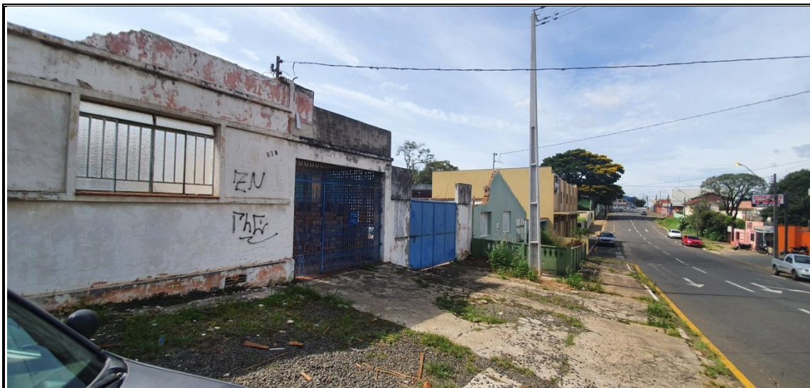
Imagem 03: Visão geral da área de instalação do edifício.
