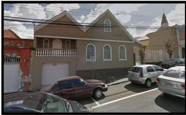
Figura 6: Edificação Anterior ao Uso Atual Fonte: Google Maps, 2017.
