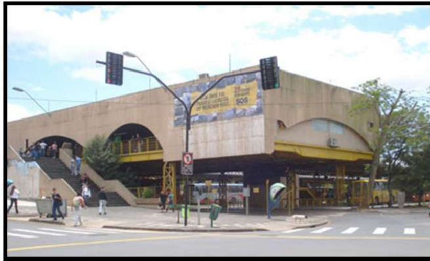
Figura 100: Terminal Central Fonte: Diário dos Campos (2012)
