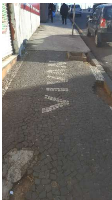
Figura 108: Calçadas adjacentes Fonte: A autora (2017)
