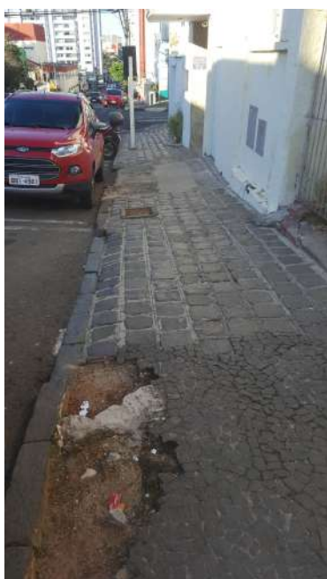
Figura 107: Calçadas adjacentes Fonte: A autora (2017)
