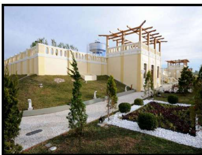
Figura 37: Reservatório de água Sanepar. Fonte: Sanepar (2014).
