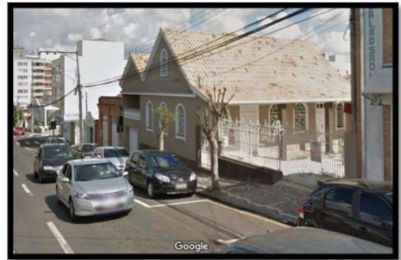
Figura 7: Edificação Anterior ao Uso Atual Fonte: Google Maps, 2017.
