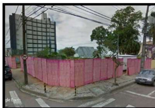
Figura 39: Casa com bosque demolida. Fonte: A autora (2017).
