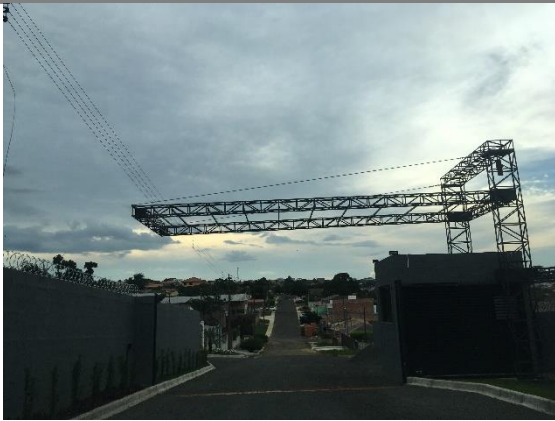
Figura 5: Vista do portal de acesso ao empreendimento. Localizado na Rua Capanema, Bairro Oficinas, Ponta Grossa – PR. Autor: Orbienge, 2021.
