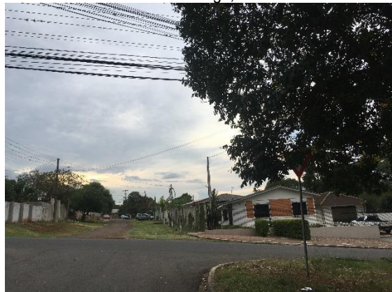
Figura 8: Esquina da Rua Mandaguaçu com a Rua Capanema, Bairro Oficinas, Ponta Grossa – PR. Autor: Orbienge, 2021.
