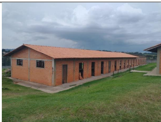
Figura 15: Edificações presentes na porção central do terreno. Autor: Orbienge, 2021.
