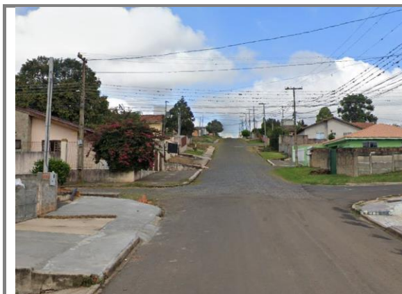
Figura 75: Vista da Rua Itambaracá esquina com a Rua Capanema com calçadas irregulares, pista de rolagem sem faixa, sem estacionamento. Fonte: Google Street View, 2019.
