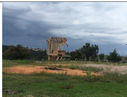
Figura 16: Edificação parcialmente demolida presente na porção central do terreno. Orbienge, 2021.
