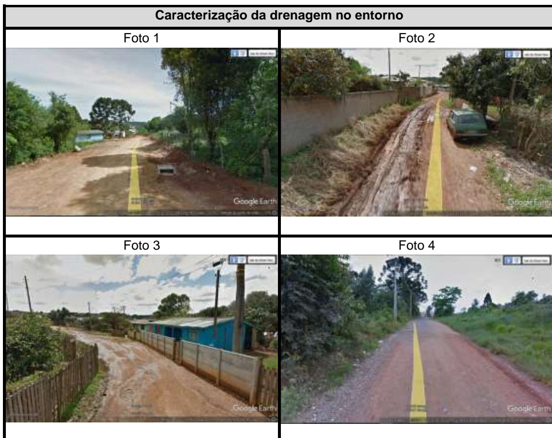
Figura 18 - Fotos de caracterização da drenagem no entorno Fonte: Google Earth, 2017.
