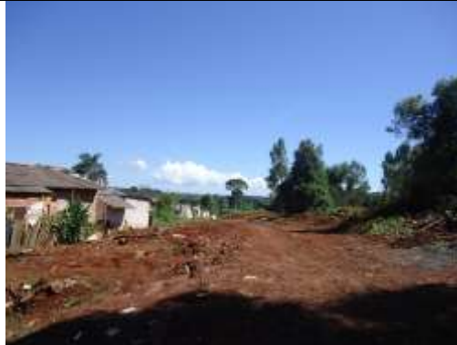
Foto 16 – Continuação da Rua Sabiá não possui asfalto, calçamento, sinalização viária e áreas de estacionamento.
