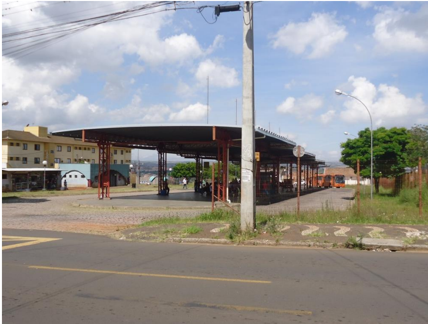
Figura 45: Terminal Urbano Central. Fonte: Master Ambiental, 2016.
