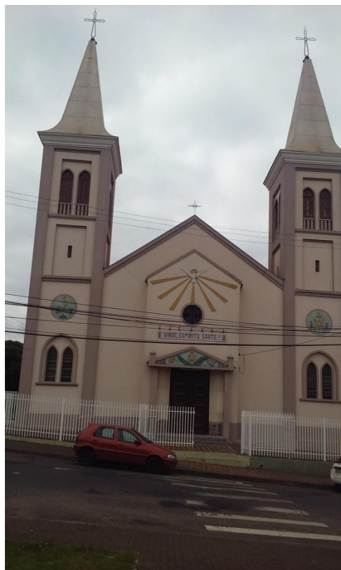
Figura 83: Igreja instalada na vizinhança. Fonte: Master Ambiental, 2016.
