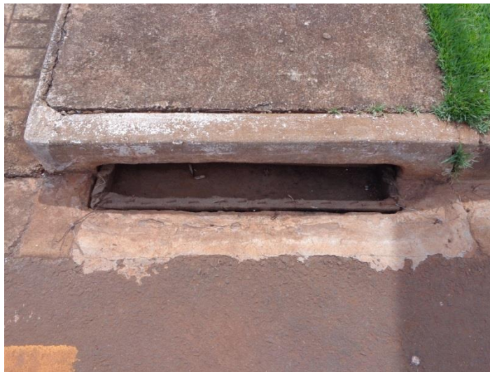
Figura 68: Sugestão de instalação de Bidin na boca de lobo para coletar material particulado. Fonte: Master Ambiental
