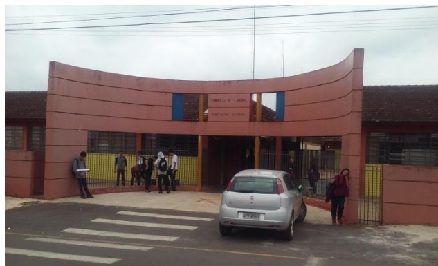
Figura 73: Colégio Estadual Espírito Santo – Rua Efigênio Costa Coelho. Fonte: Master Ambiental, 2016.
