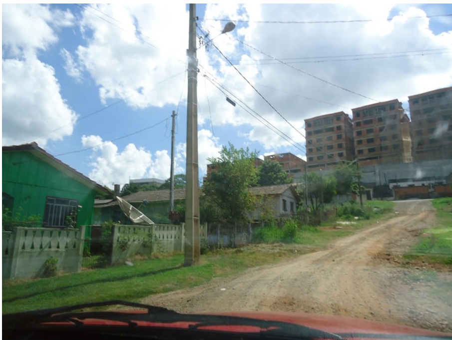
Figura 62: Iluminação pública da Rua Brasil, atrás do empreendimento. Fonte: Master Ambiental, 2016.
