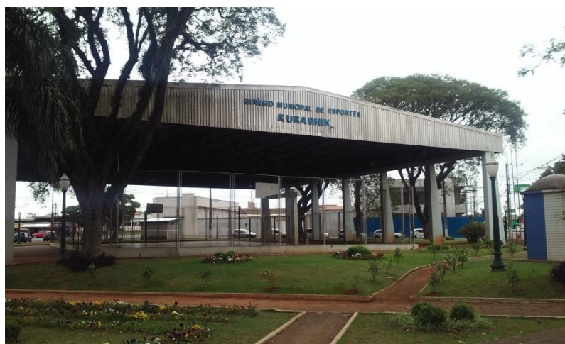
Figura 77: Ginásio Municipal de Esportes Kurashiki. Fonte: Master Ambiental, 2016.
