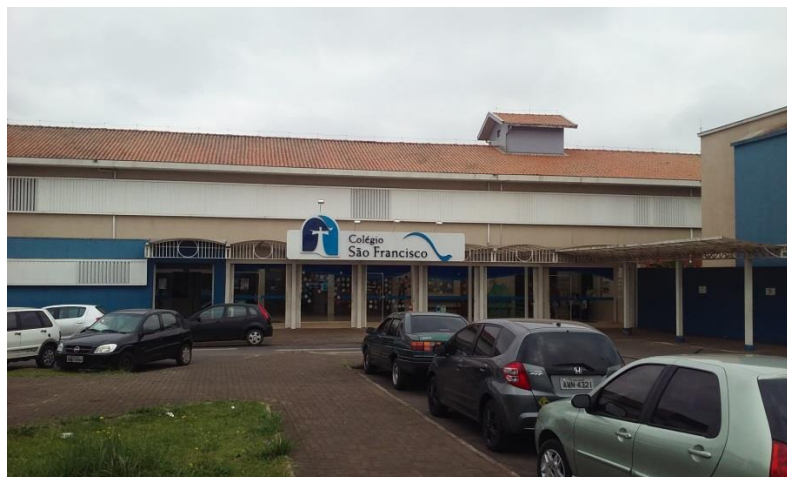
Figura 76: Colégio particular São Francisco. Fonte: Master Ambiental, 2016.
