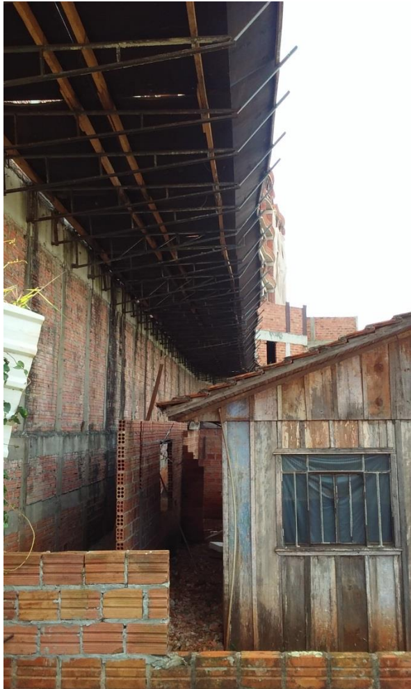
Figura 15: Residência limítrofe a obra do empreendimento. Fonte: Master Ambiental, 2016.
