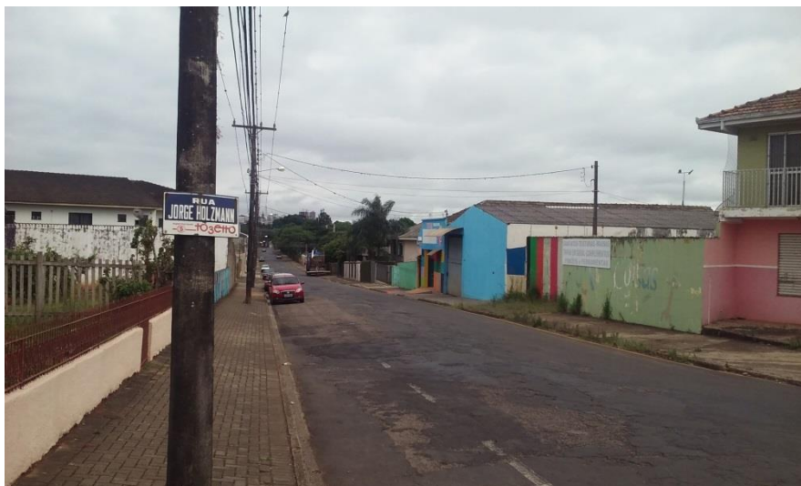
Figura 59: Rua Jorge Holzmann - arborização viária inexistente. Fonte: Master Ambiental, 2016.
