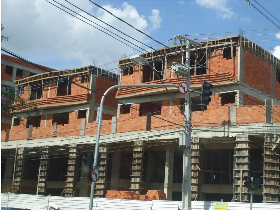
Figura 61: Poste de iluminação noturna na Avenida Visconde de Mauá. Fonte: Master Ambiental, 2016.
