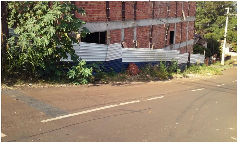
Figura 56: Calçada do empreendimento - Rua Durval da Silva. Fonte: Master Ambiental, 2016.
