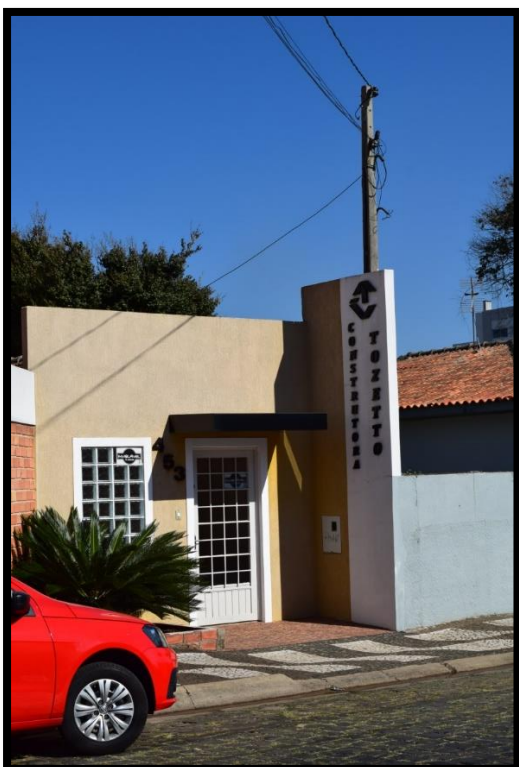
Figura 111: Construtora Tozetto – Rua Prudente de Moraes nº453 Fonte: A Autora (2017)
