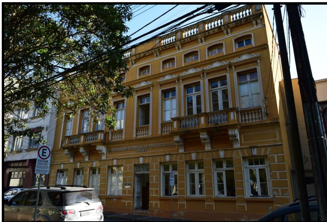
Figura 179: Edifício Guilherme Neumann– Rua Santana nº10 - Praça Marechal Floriano Peixoto
