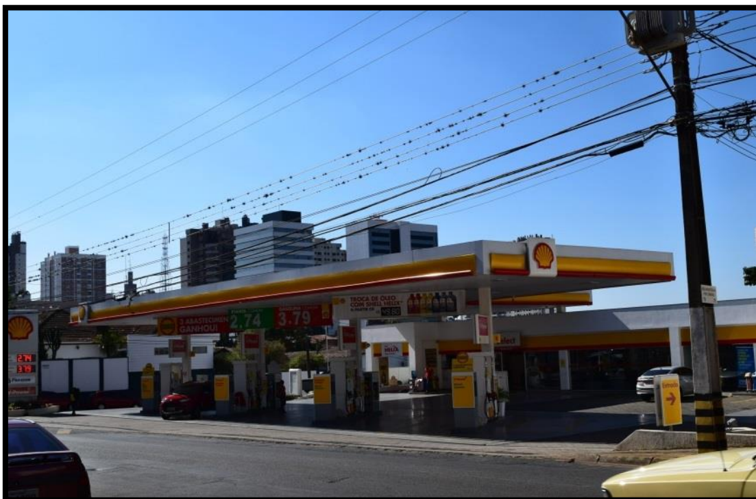
Figura 92: Posto Florence Shell – Rua Doutor Paula Xavier esquina com Rua Amazonas
