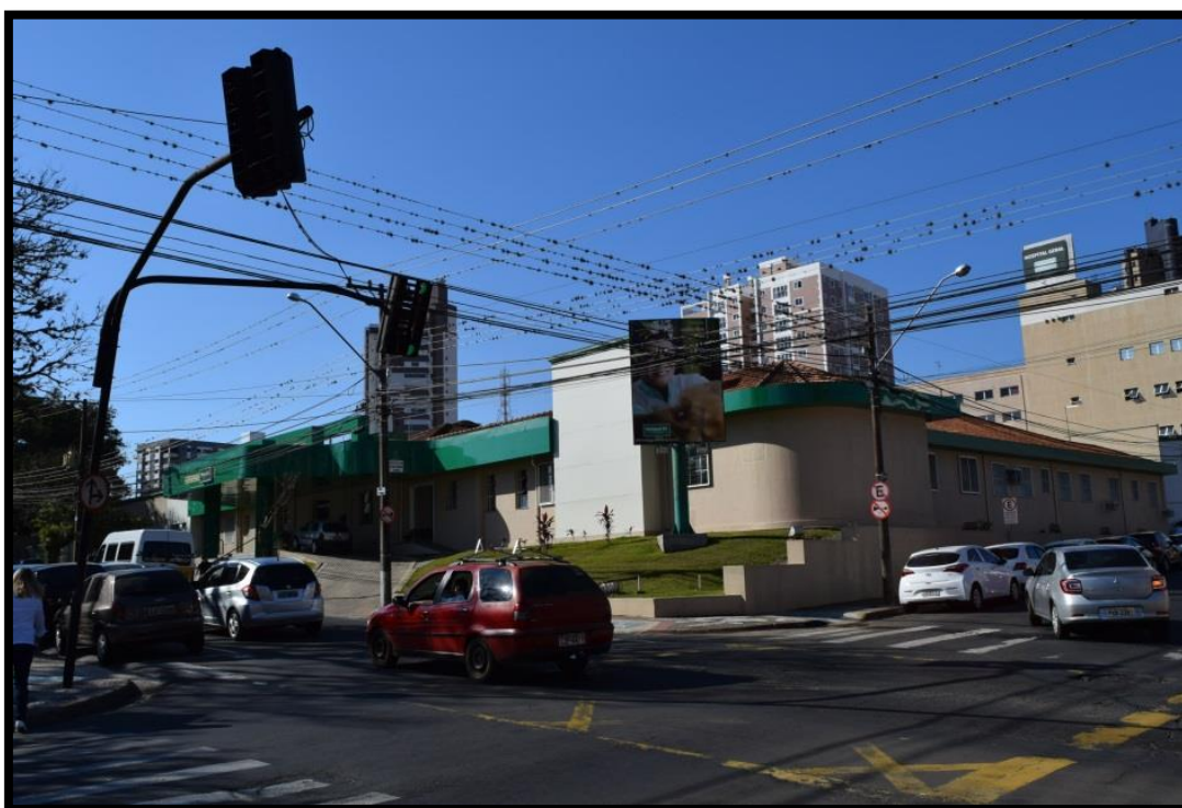
Figura 129: Hospital Geral Unimed– Rua Carlos Osternack nº144 Fonte: A Autora (2017)
