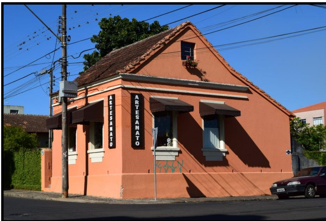
Figura 114: Artesanato Pont Artes – Rua Amazonas nº 261
