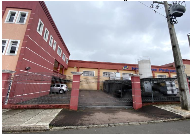
Figura 94: Acesso de veículos Rua Tomaz Gonzaga - estacionamento condôminos.
