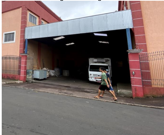
Figura 99: Acesso carga e descarga Rua Tomaz Gonzaga.
