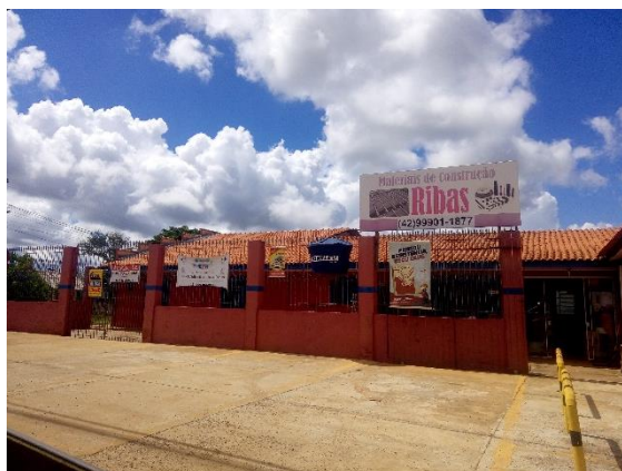
Figura 20: Material de construções. Autor: Orbienge.
