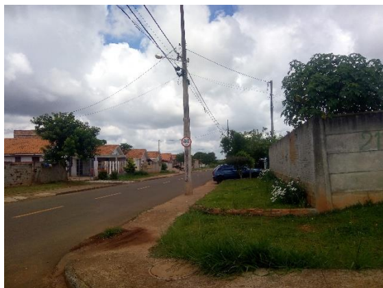
Figura 48: Rampa de acessibilidade executada na esquina da Rua João Borsato com a João Henrique Stanislawczuk. Autor: Orbiengce.
