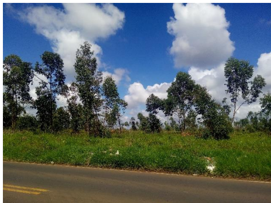
Figura 50: Ausência do passeio executado na Avenida Pedro Vosgrau, sentido Centro. Autor: Orbienge.
