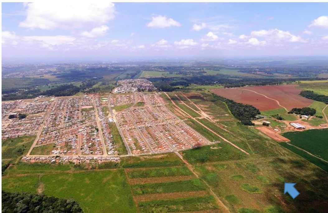
Figura 44 – Vista do empreendimento ao lado Leste. Fonte: Dados coletados em campo.
