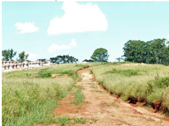
Figura 19 – Vista para o futuro acesso à Avenida Eduardo Burgardt.
