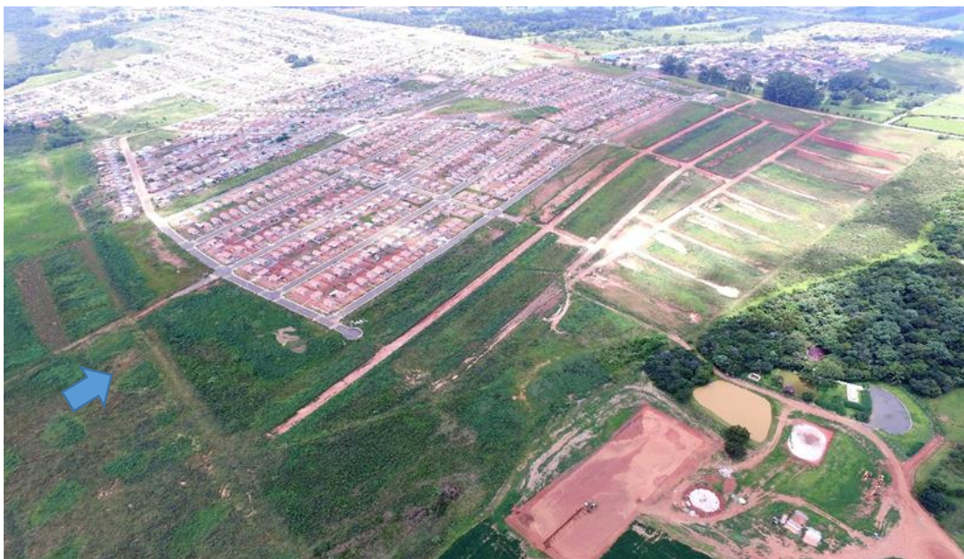
Figura 42– Vista do empreendimento ao lado Norte. Fonte: Dados coletados em campo.
