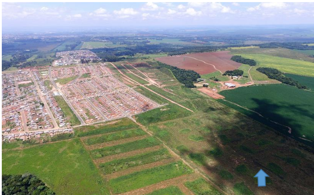
Figura 45 – Vista do empreendimento ao lado Sudeste. Fonte: Dados coletados em campo.
