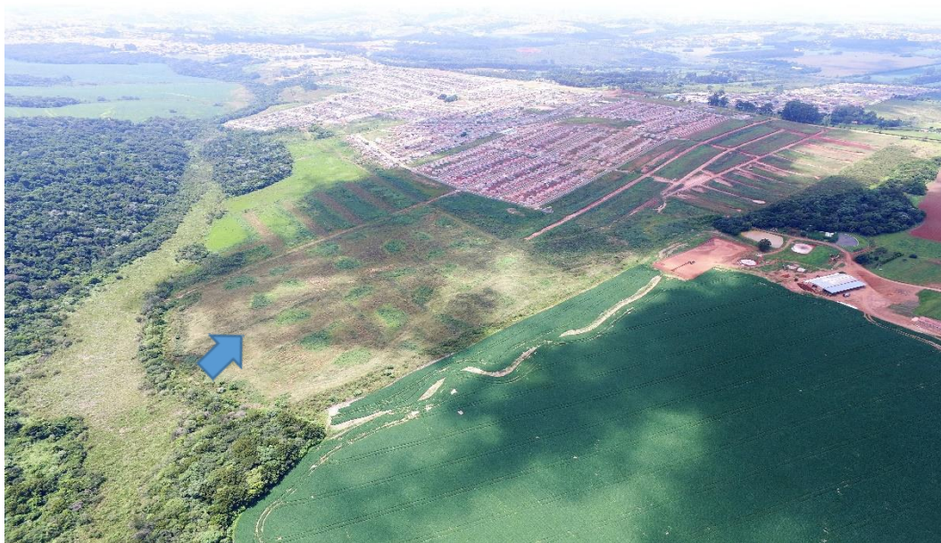
Figura 43 – Vista do empreendimento ao lado Nordeste. Fonte: Dados coletados em campo.
