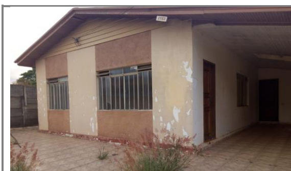
Figura 14: Edificação presente no Lote 12/A. Autor: Orbieng, 2021.
