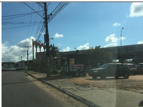
Figura 117: Vista parcial do passeio localizado na Rua Vicente Spósito, no trecho com coordenadas X: 589.261 e Y: 7.224.506. Autor: Orbienge, 2021.
