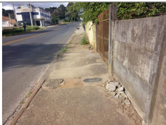
Figura 114: Vista do passeio em frente ao lote do empreendimento na Alameda Nabuco de Araújo, com coordenadas X: 589.694 e Y: 7.224.408. Autor: Orbieng, 2021.
