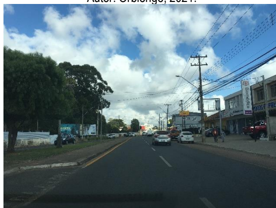
Figura 116: Vista parcial do passeio na Avenida Carlos Cavalcanti, no trecho com coordenadas X: 589.187 e Y: 7.224.590. Autor: Orbieng, 2021.
