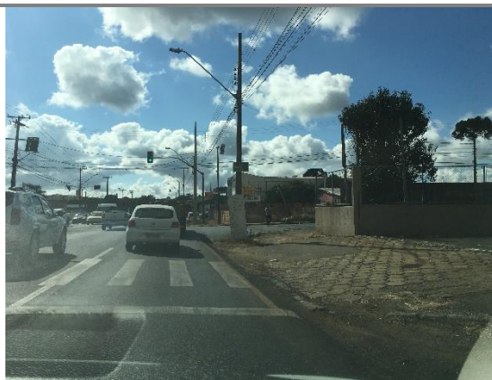
Figura 109: Semáforo localizado na Rua Vicente Spósito com a Rua Teixeira Mendes. Autor: Orbieng, 2021.
