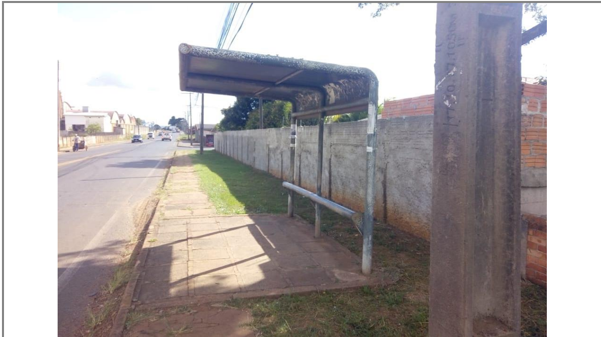
Figura 111: Parada de ônibus localizada na Alameda Nabuco de Araújo, sentido bairro – centro. Autor: Orbienge, 2021.
