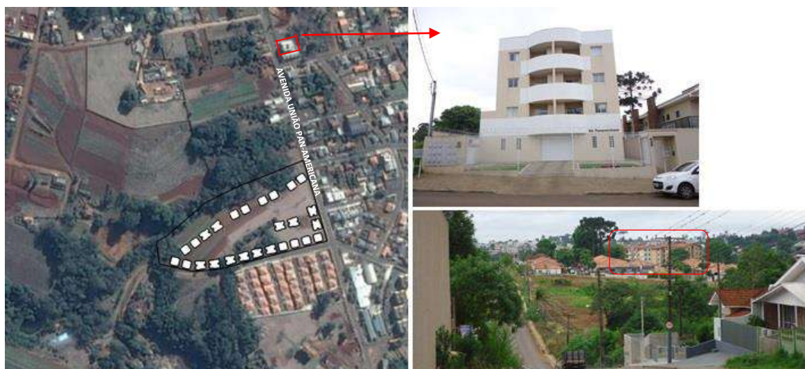
Figura 10 – Edifício Panamericano: habitações coletivas verticais existentes no entorno.
