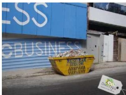
Foto 37 - Exemplo de caçamba estacionária. Fonte: Obra do Edifício Eurobusiness (2015).
