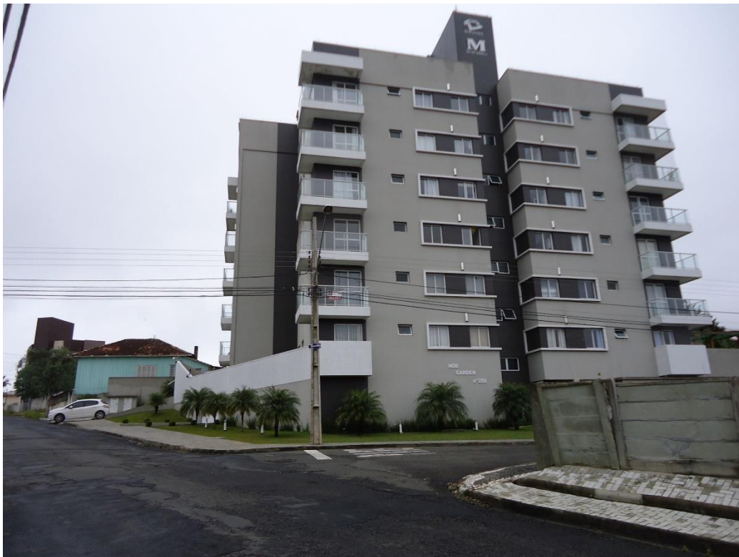
Foto 21 – Edifício localizado na intercessão da Rua Cruz e Souza com a Rua Marques de Maricá.
