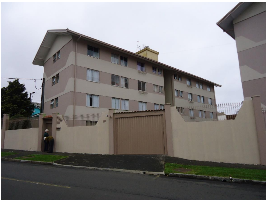
Foto 12 - Prédio de pequeno porte, esquina com a Rua Marques de Maricá.
