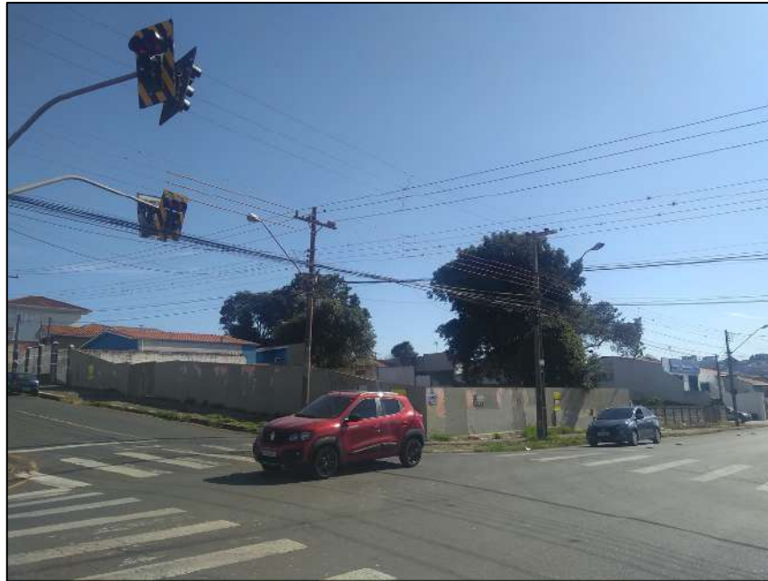
Figura 44. Rede de energia elétrica.
