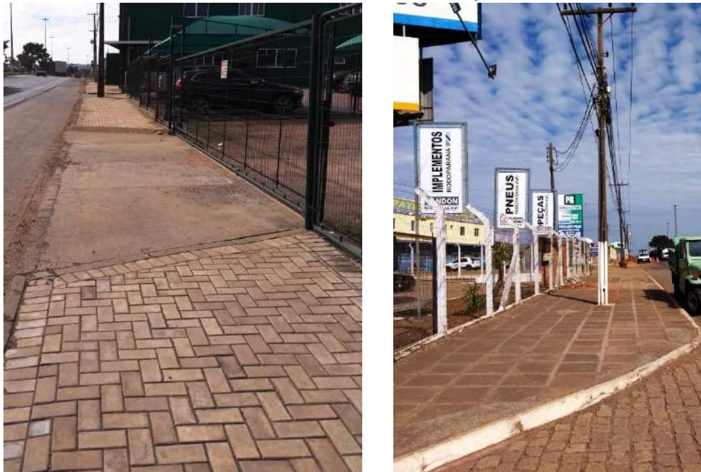
Fotos 25 e 26 – Passeio nos lotes adjacentes
