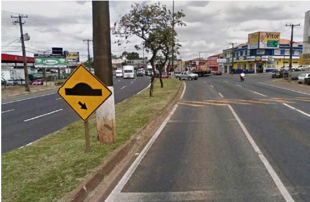
Foto 4 – Sinalização vertical, horizontal e lombada – 550 m antes do PGT
