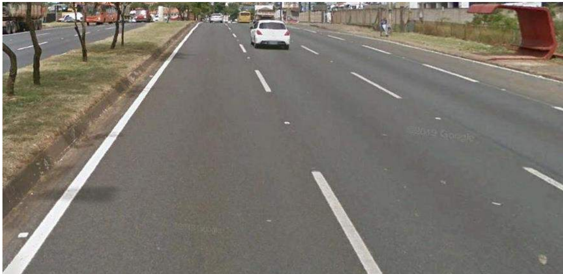
Foto 9 – Sinalização vertical e horizontal – em frente ao PGT
