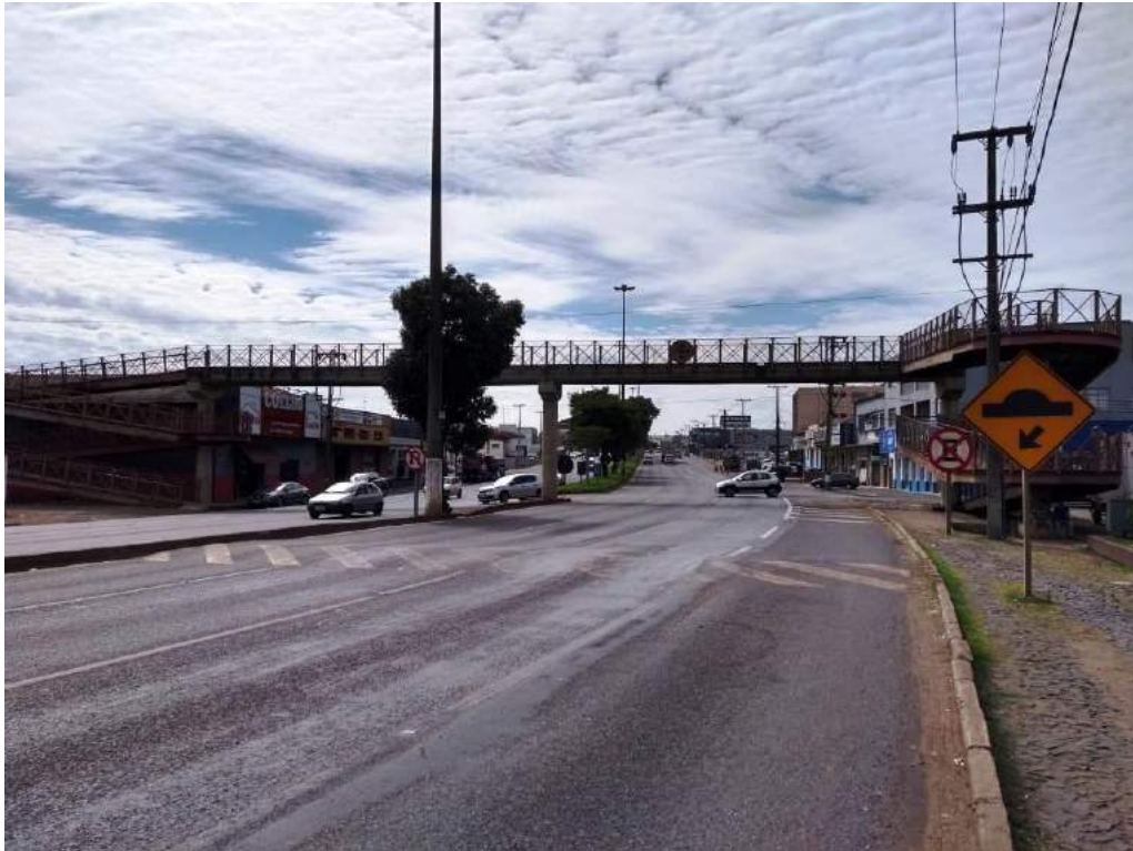
Foto 6 – Sinalização vertical e horizontal – 350 m antes do PGT
