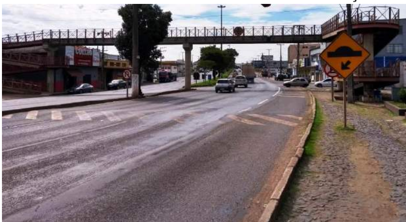
Foto 20 – Entroncamento Av. Souza Naves x Av. Melvin Jones – sinalização antes do cruzamento
