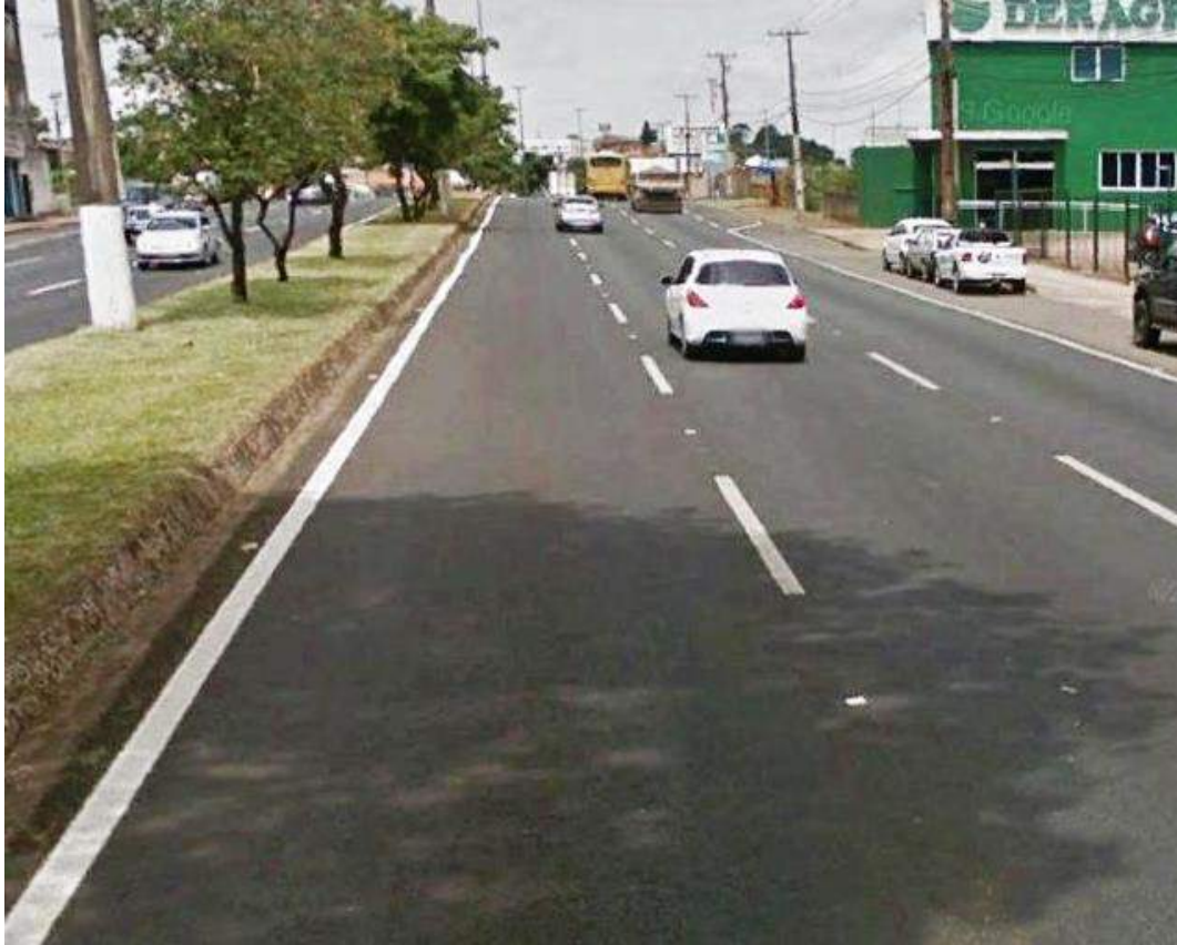
Foto 8 – Sinalização vertical e horizontal – 100 m antes do PGT
