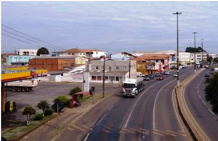
Foto 19 – Entroncamento Av. Souza Naves x Av. Melvin Jones – vista panorâmica
