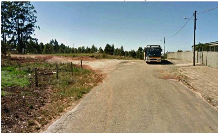
Foto 22 – Rua a ser prolongada
