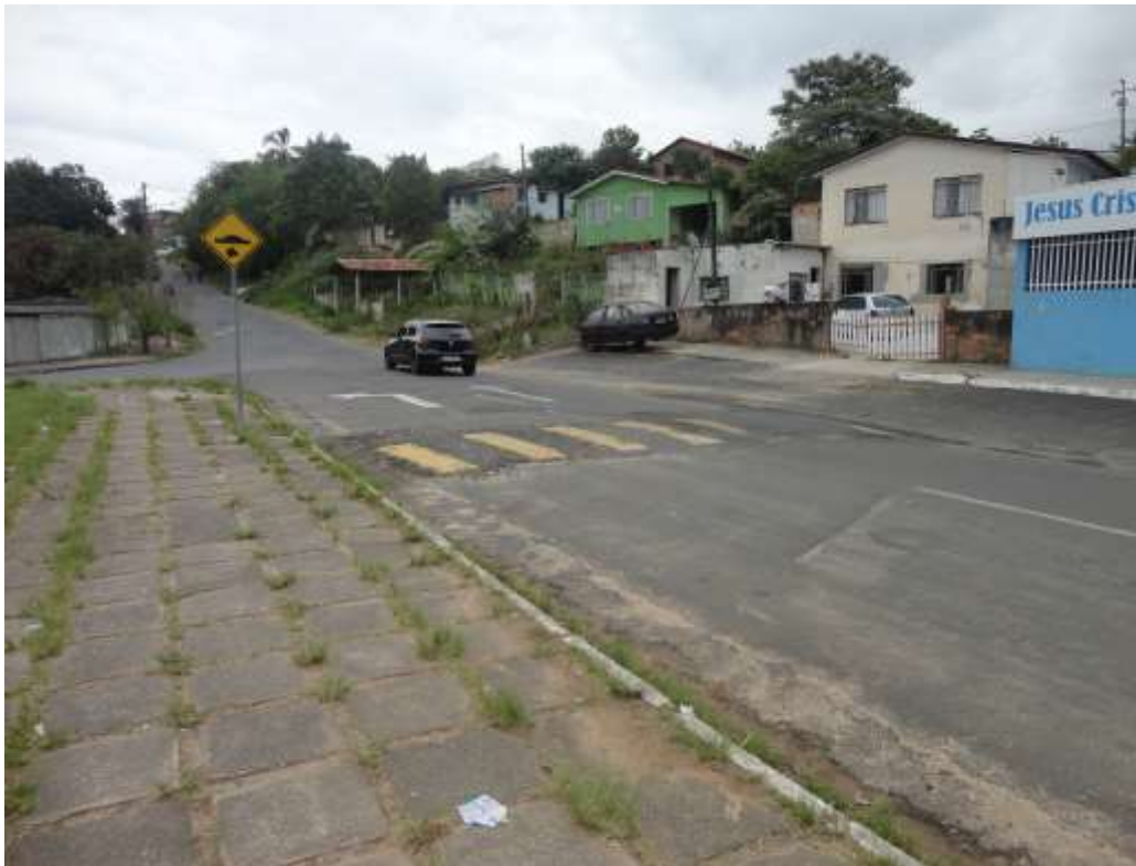
Foto 7 – Placa indicativa de lombada e sinalizações de sentido na pista da Rua Sertaneja.
