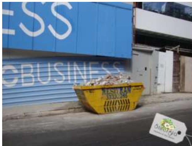
Foto 24 - Exemplo de caçamba estacionária. Fonte: Obra do Edifício Eurobusiness (2015).
