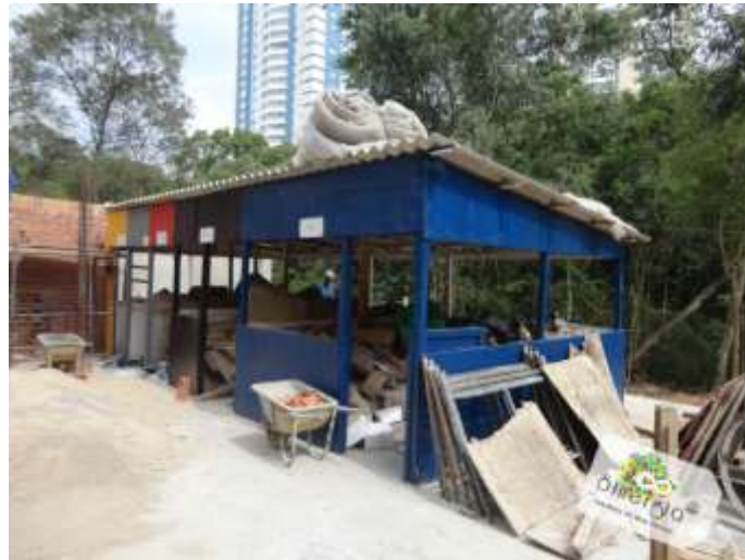
Foto 21 - Modelo de baia para o armazenamento de resíduos. Fonte: Obra do Edifício Eurobusiness (2015).
