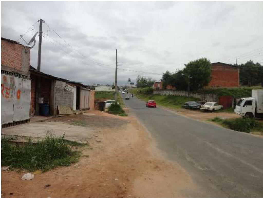
Foto 17 – Vista para a Rua Baltazar Lisboa nas imediações do empreendimento.
