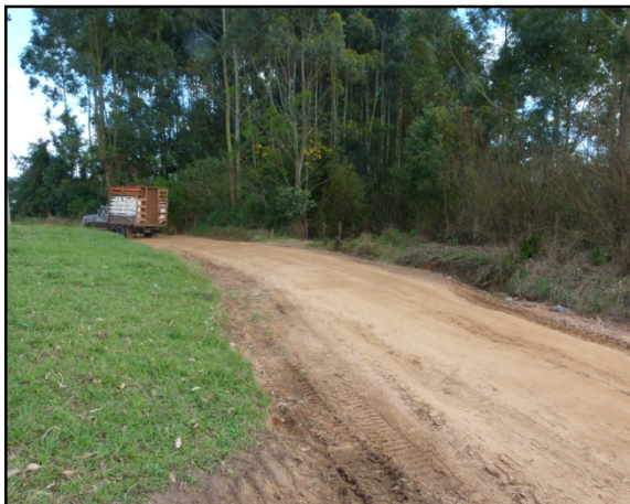
Figura 15 - Rua Arno Wolf sem pavimentação
