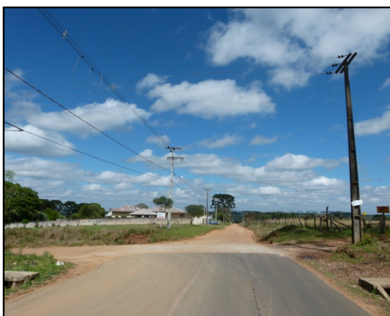
Figura 13 - Rua Arno Wolf com pavimentação.
