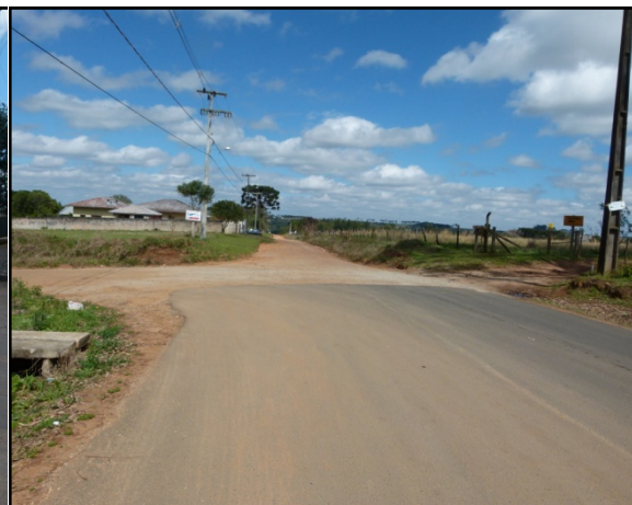
Figura 12 - Final da Rua Arno Wolf com pavimentação.
