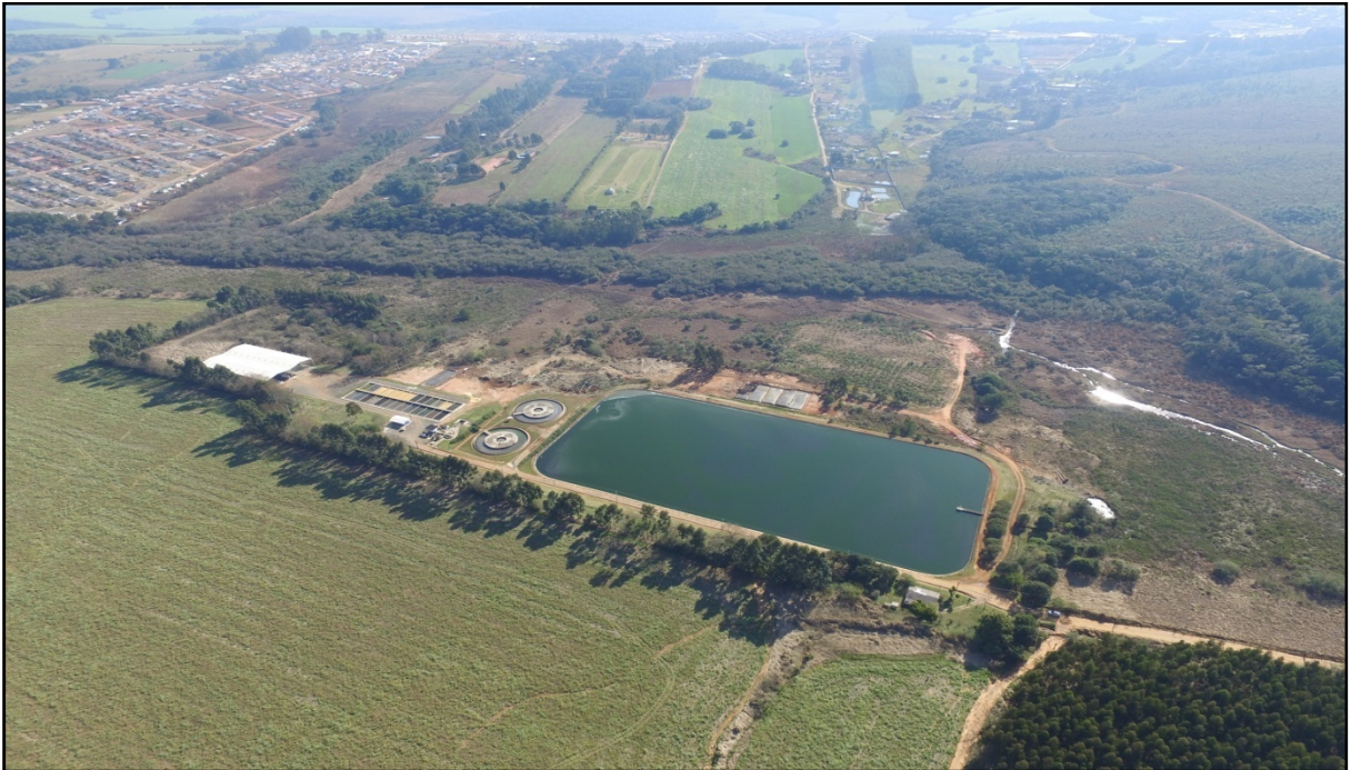
Figura 47 – Vista do empreendimento ao lado Noroeste. Fonte: Dados coletados em campo.
