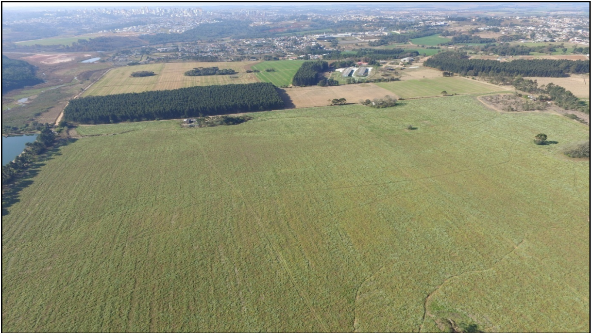
Figura 41 – Vista do empreendimento ao lado Nordeste. Fonte: Dados coletados em campo.
