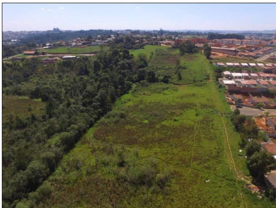
Vista aérea a montante do empreendimento – sentido NE
