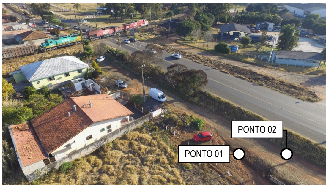
Figura 35 – Pontos de medição do ruído. Fonte: Dados coletados em campo.
