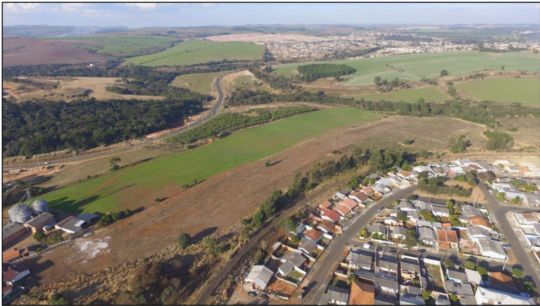
Figura 27 – Vista do empreendimento ao lado Nordeste. Fonte: Dados coletados em campo.
