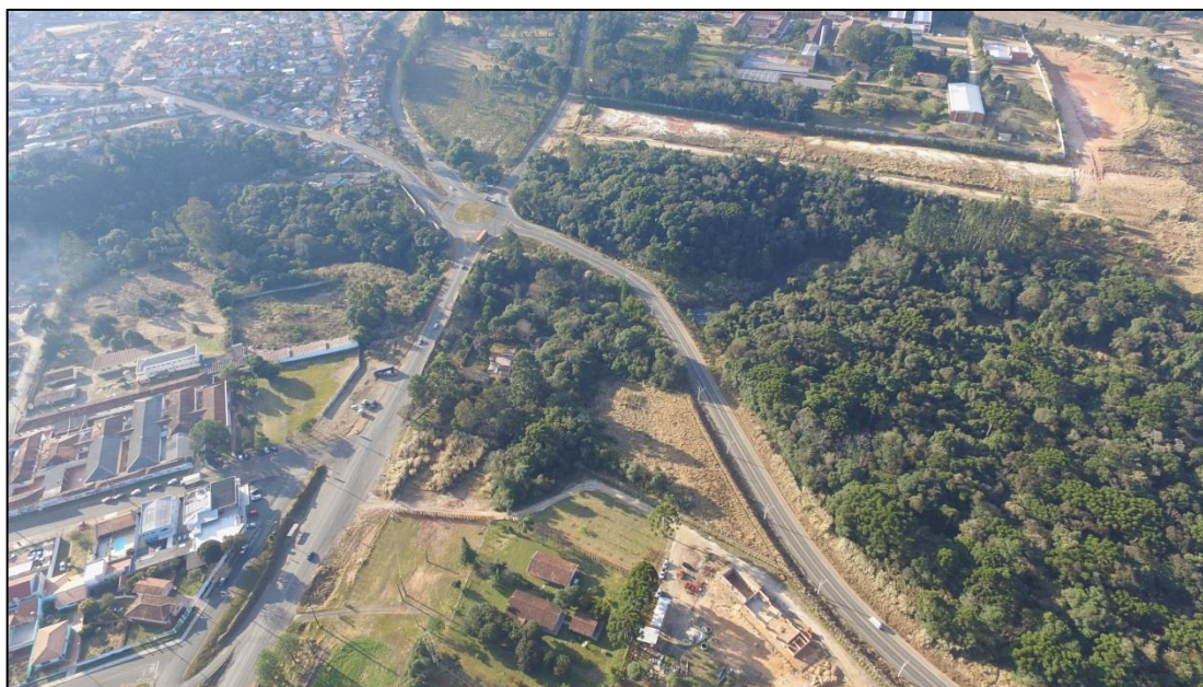
Figura 26 – Vista do empreendimento ao lado Norte. Fonte: Dados coletados em campo.
