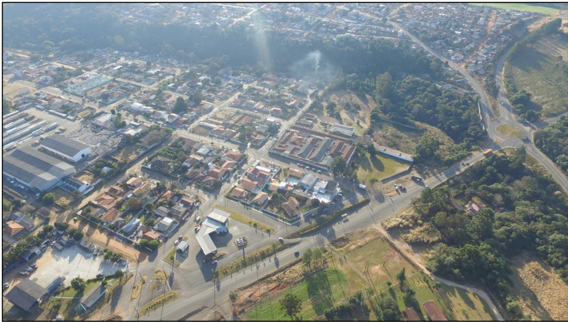
Figura 33 – Vista do empreendimento ao lado Noroeste. Fonte: Dados coletados em campo.
