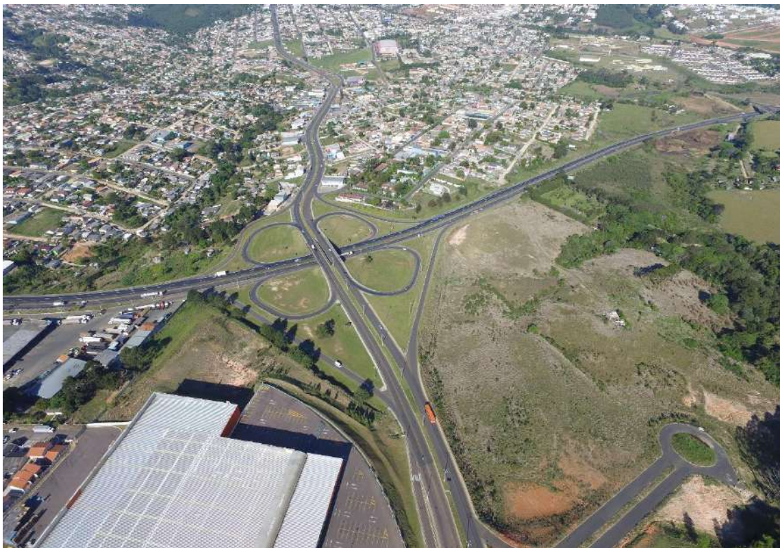
Figura 5: Vista aérea da Rodovia do Café, sentido capital do estado. Fonte: ORBIENGE.
