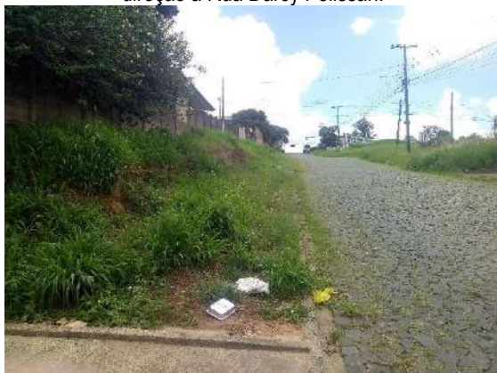
Figura 73: Situação do passeio da Rua República da Colômbia, em direção à Avenida Visconde de Taunay.
