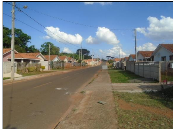
Figura 11 – Rua José Borsato, loteamento Residencial Recanto Verde, acesso ao loteamento.
