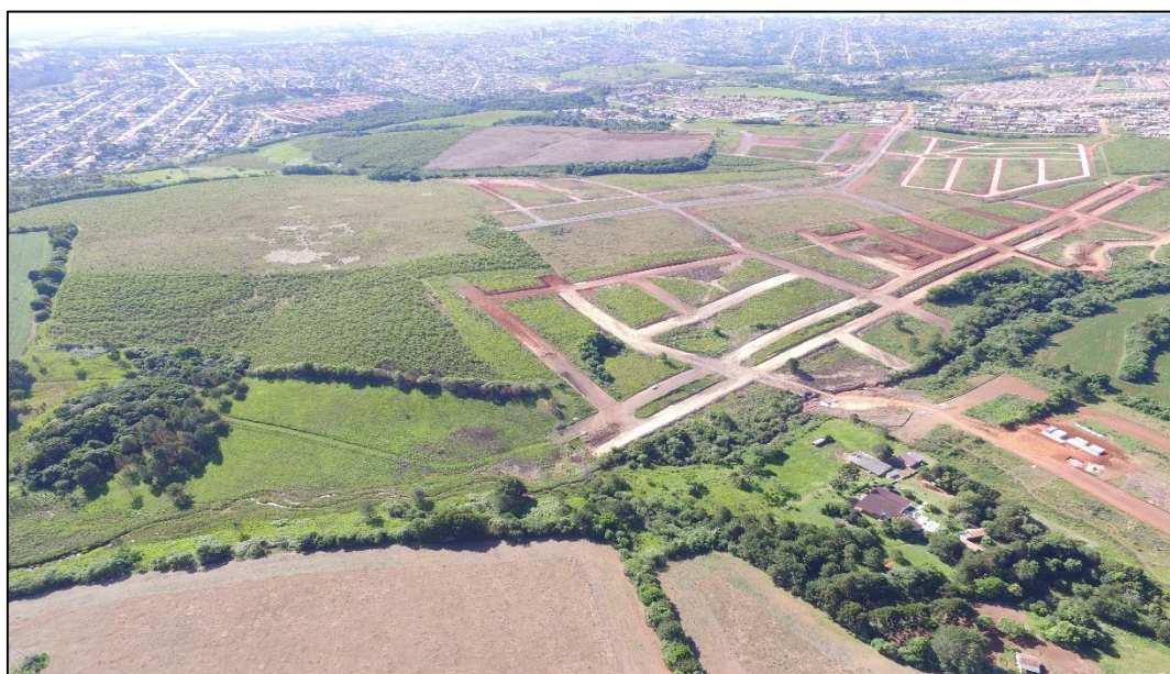
Figura 42 – Vista do empreendimento ao lado Noroeste. Fonte: Dados coletados em campo.
