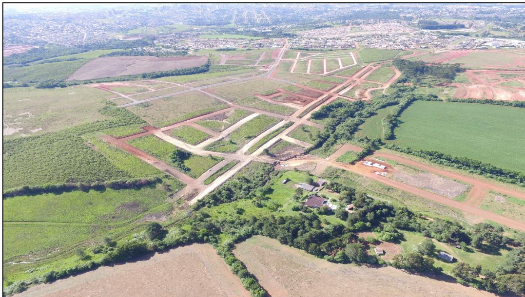
Figura 35 – Vista do empreendimento ao lado Norte. Fonte: Dados coletados em campo.
