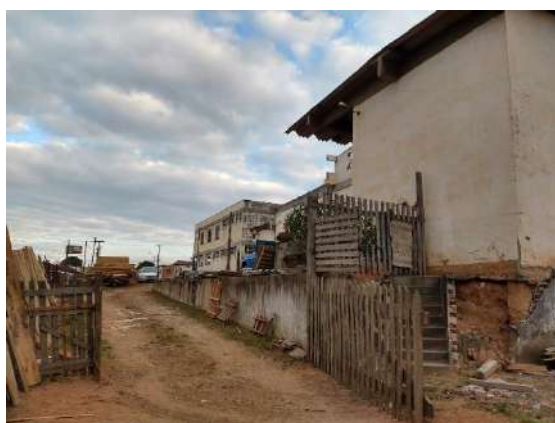
Figura 7: Edificação existente a ser demolida.
