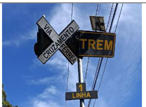
Figura 90: Semáforo localizado na Rua Rio Verde, interseção com a linha férrea. Autor: Orbienge, 2021.
