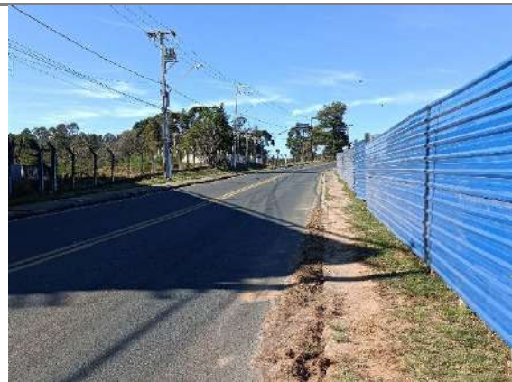
Figura 95: Vista do passeio em frente ao lote do empreendimento na Rua Valério Ronchi. Autor: Orbienge, 2021.
