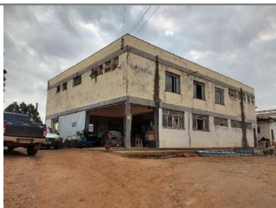
Figura 4: Edificação existente a ser demolida.
