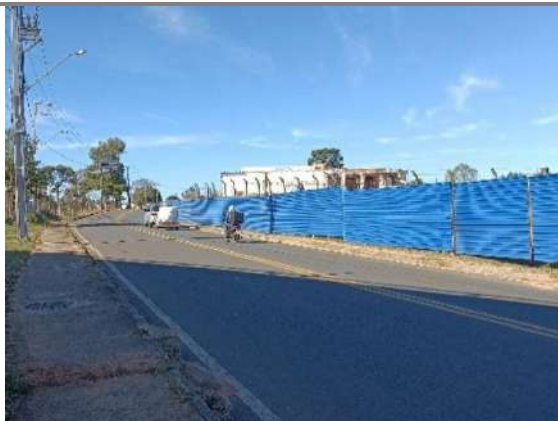
Figura 80: Vista da Rua Valério Ronchi, sentido ao local do empreendimento centro – bairro.
