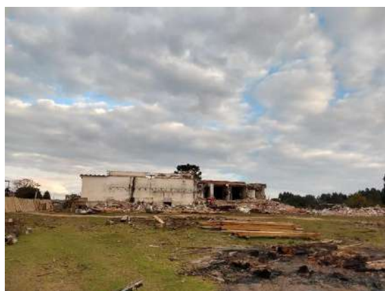
Figura 6: Edificação existente a ser demolida.
