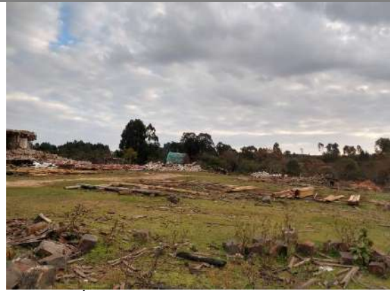
Figura 9: Área parcial com vista de edificações a serem demolidas.
