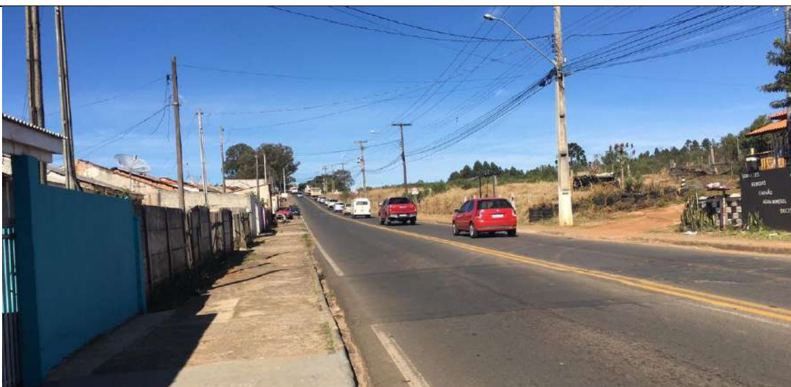
Figura 79: Vista da Rua Valério Ronchi, sentido ao local do empreendimento centro – bairro.
