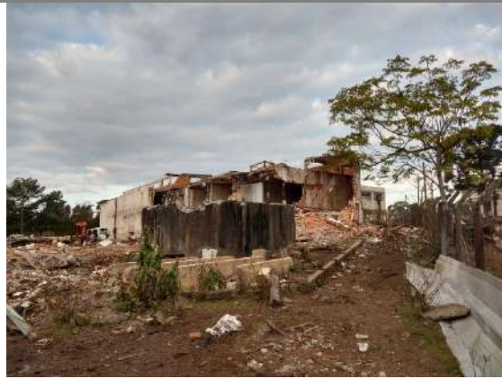
Figura 8: Edificação existente a ser demolida.
