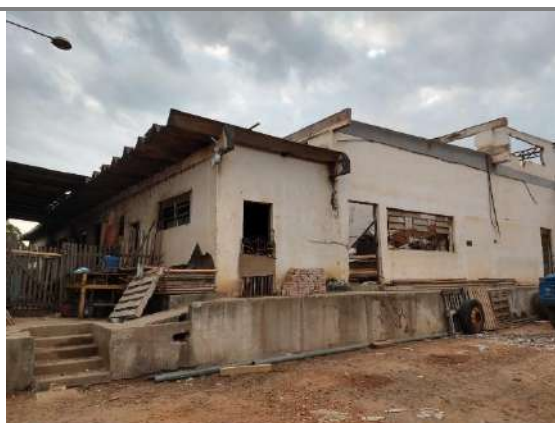
Figura 5: Edificação existente a ser demolida.
