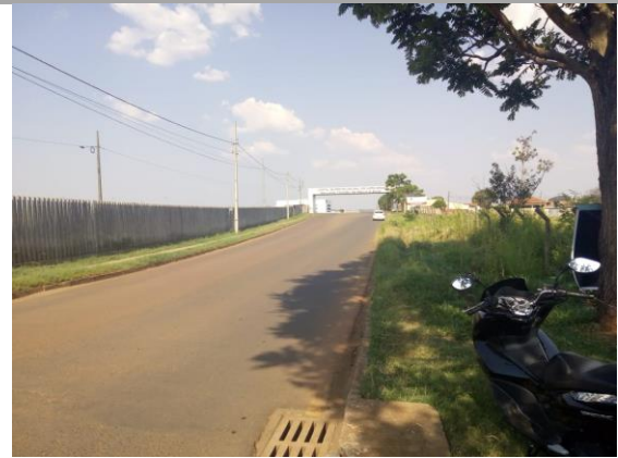
Figura 63: Situação da calçada da Rua Prof. Gabriel de Paula Machado, no trecho oposto ao que faz frente ao empreendimento, em direção ao H.U.
