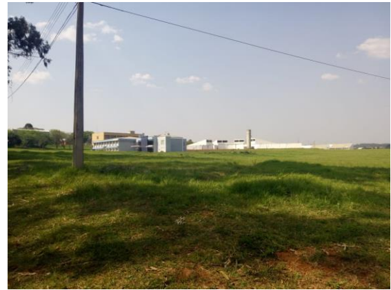
Figura 6: Vista do terreno de implantação em direção ao Bloco de Zootecnia.
