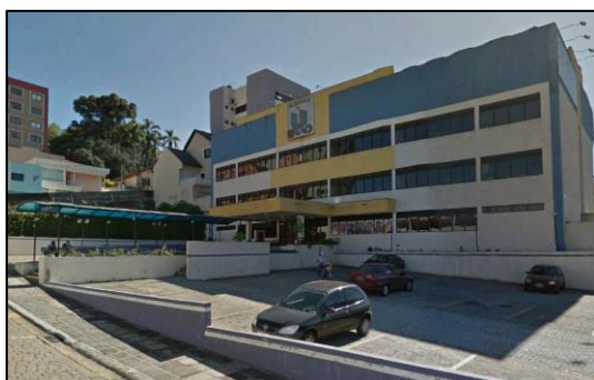
FACULDADE UNIÃO E EDIFICAÇÃO RESIDENCIAL EM EXECUÇÃO, COM FACHADA HISTÓRICA PRESERVADA.
