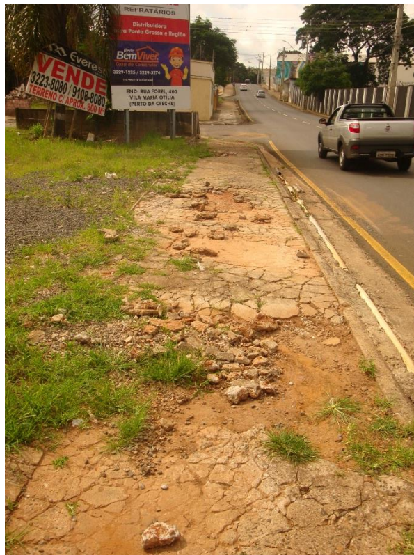
Figura 44: Calçada em frente ao segundo lote Fonte: A autora (2017)
