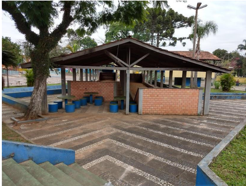
Figura 8 - Estrutura para prática de bocha na Praça Getúlio Vargas. Fonte: Autor (2019).
