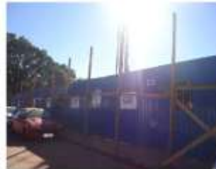
Ponto 8 - Construção na R. Amazonas, Edifício Life Residence 25° 6'22.29"S - 50° 9'45.47"O
