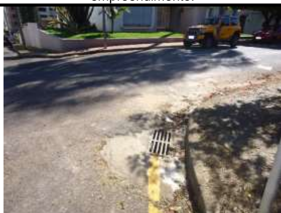
Foto 9 - Boca de lobo em frente ao empreendimento.
