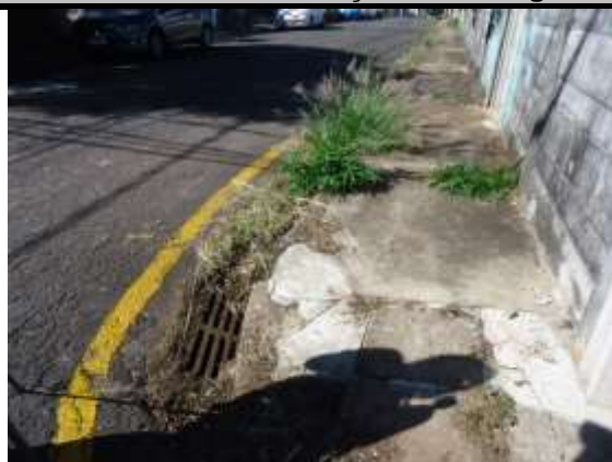
Foto 7 - Boca de lobo no entorno do empreendimento.
