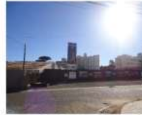
Ponto 10 - Construção na R. Padre Nóbrega 25° 6'29.78"S - 50° 9'53.59"O
