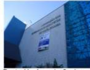
Ponto 11 - Associação dos Engenheiros e Arquitetos PG 25° 6'18.27"S - 50° 9'41.32"O
