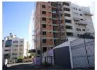
Ponto 3 - Construção na R. Teixeira Soares 25° 6'28.23"S - 50° 9'49.10"O
