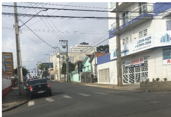
Figura 3: Vista da esquina da Rua Coronel Dulcídio (futuro acesso ao empreendimento).
