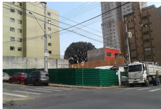
Figura 4: Vista da esquina da Rua Riachuelo com a Rua Coronel Dulcídio.
