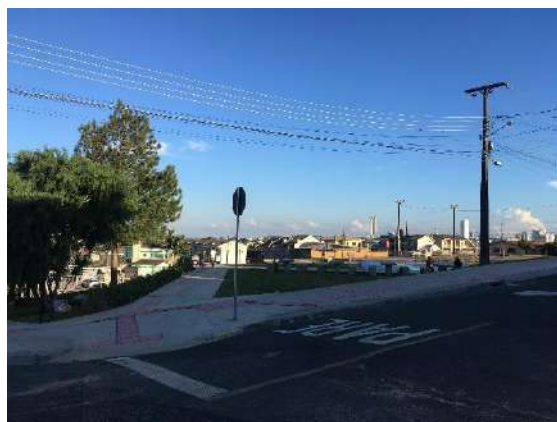
Figura 92: Execução de piso tátil. Autor: ORBIENGE, 2021.
