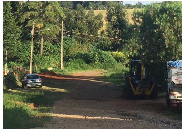
Figura 7: Vista da Rua Antônio Vitor Buhneman, via de acesso a área do imóvel Condomínio Otto 2.
