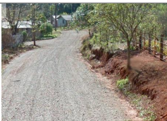
Figura 2: Vista da Rua Antônio Malaquias, via de acesso a área do imóvel do Condomínio Otto 1.
