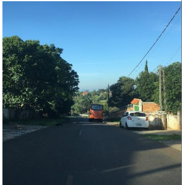
Figura 78: Situação da Rua José Antunes Mendes, parcialmente com calçada irregulares, sem meio fio e pista de rolagem sem faixa de estacionamento.
