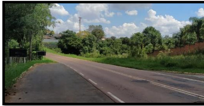
Figura 56 - Vista da Estrada Ponta Grossa-Castro sem passeio, iluminação pública e acostamento
