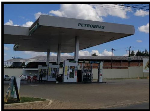
Figura 34 - Posto de combustível
