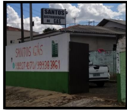
Figura 31 - Distribuidora de gás
