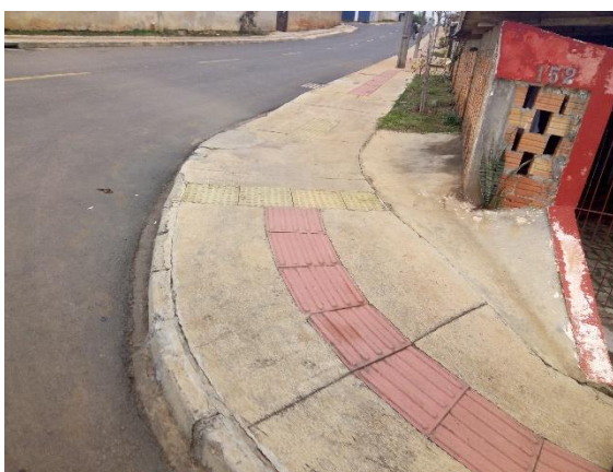
Figura 74: Situação da Rua Jesuíta já adequada para PNE.
