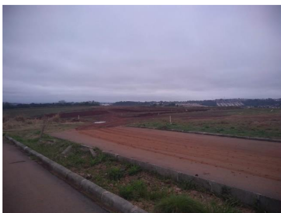
Figura 73: Situação da Rua Sem Denominação que dá acesso ao empreendimento.
