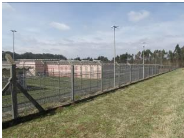
Figura 11: Visualização da Penitenciária Estadual de Ponta Grossa (PEPG), próximo à frente ao terreno. Vista sentido leste. (fonte: Arquivo SESP-PR)
