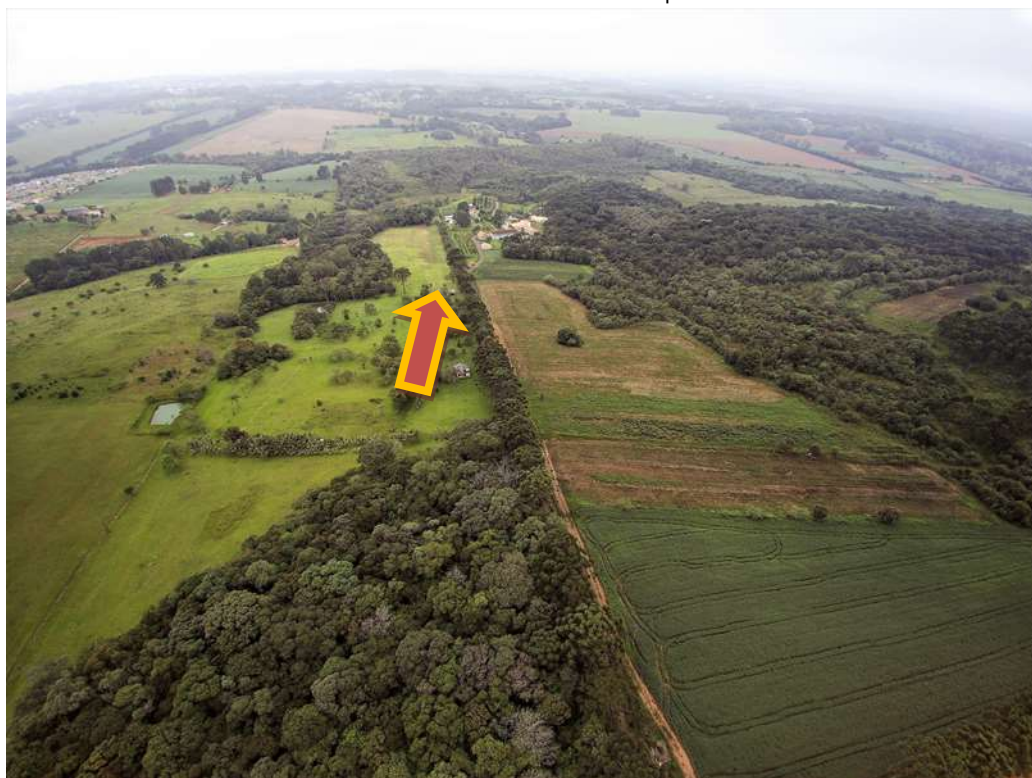
Figura 62 – Vista do empreendimento ao lado Leste. Fonte: Dados coletados em campo.
