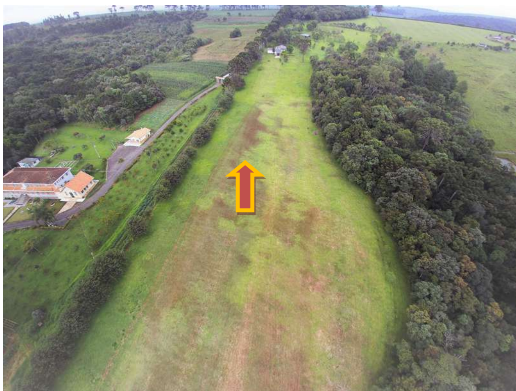
Figura 66- Vista do Empreendimento ao lado Oeste. Fonte: Dado coletado em campo.
