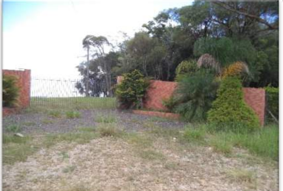
Figura 36 – Vista atual da entrada para o imóvel.
