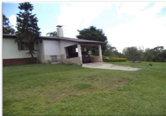
Figura 39 – Vista para edificação existente na área do futuro empreendimento.
