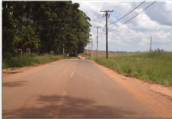
Figura 33 - Vista mais próxima para a o início da Avenida Eduardo Burgardt..
