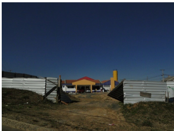
Escola Particular – Em construção
