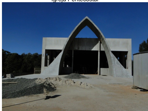
Igreja (em construção)
