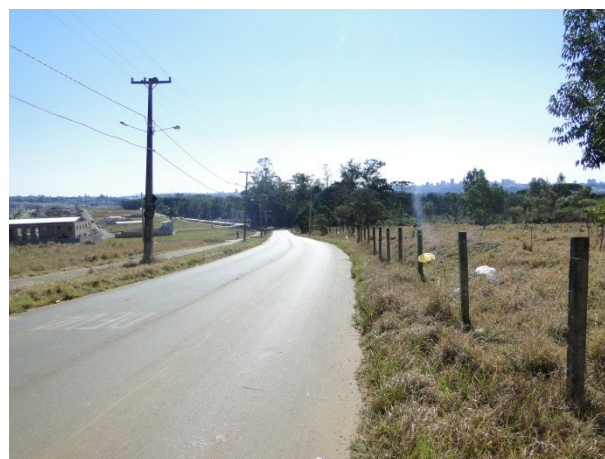
Sistema de Iluminação Pública – Rua Antônio Burgardt
