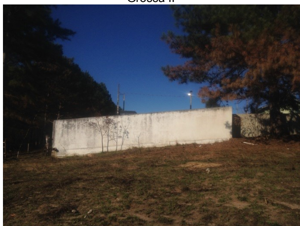
Estação elevatória da SANEPAR localizada aos fundos do terreno do Subcondomínio Ponta Grossa II
