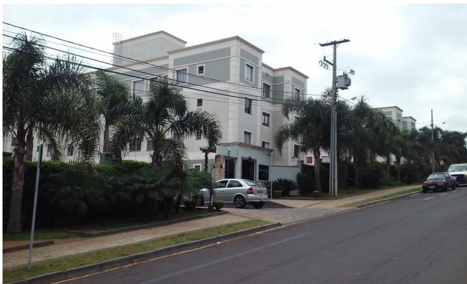
Figura 30: Residencial Portal dos Frades. Fonte: Master Ambiental, 2016.
