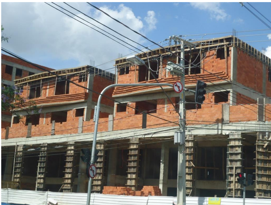
Figura 60: Poste de iluminação noturna na Avenida Visconde de Mauá. Fonte: Master Ambiental, 2016.
