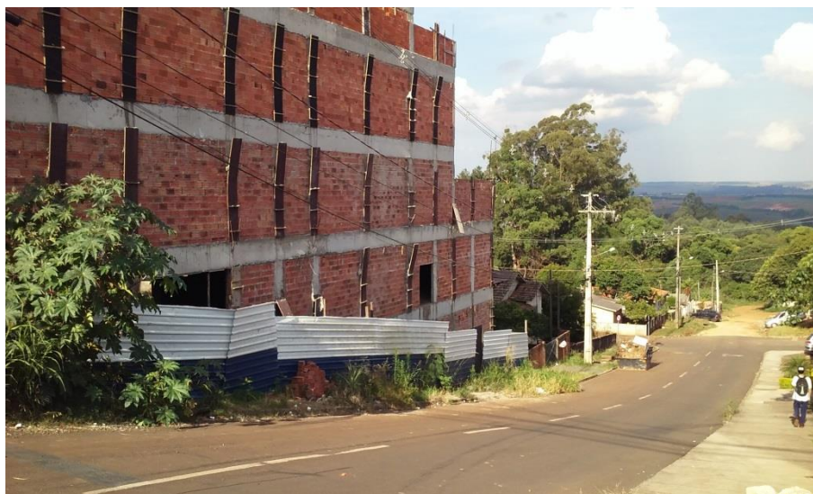
Figura 62: Iluminação pública da Rua Durval da Silva. Fonte: Master Ambiental, 2016.
