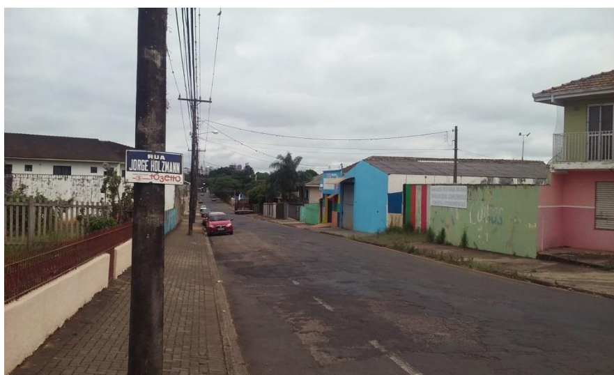
Figura 58: Rua Jorge Holzmann - arborização viária inexistente. Fonte: Master Ambiental, 2016.
