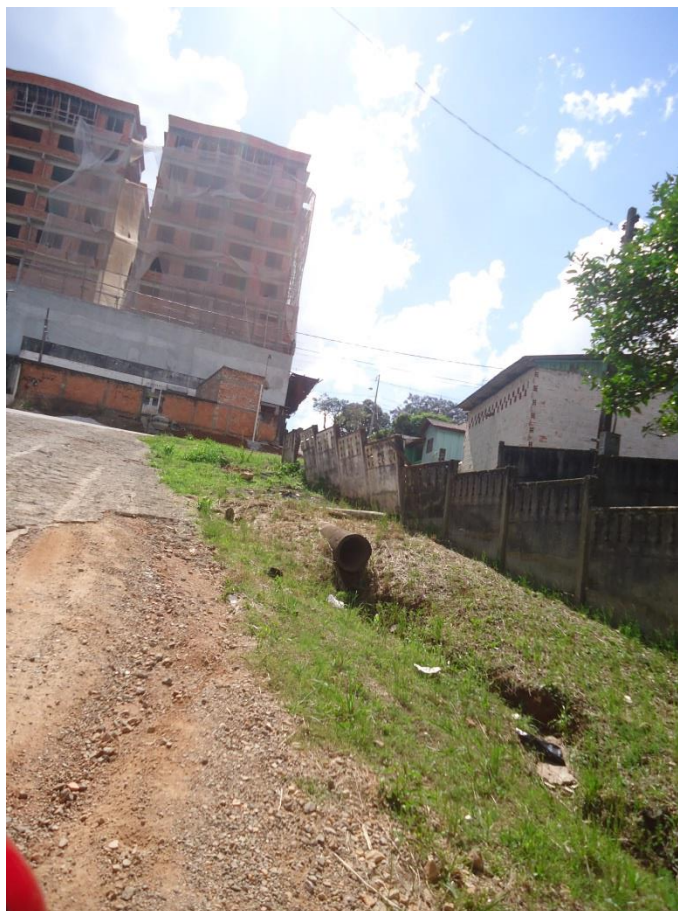
Figura 68: Manilha de descarte de águas pluviais ao fundo do lote do empreendimento Residencial Mauá.
