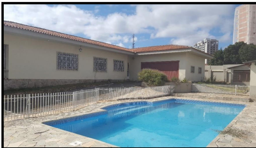
Figura 7: Edificação existente área de estudo Fonte: A autora (2017)
