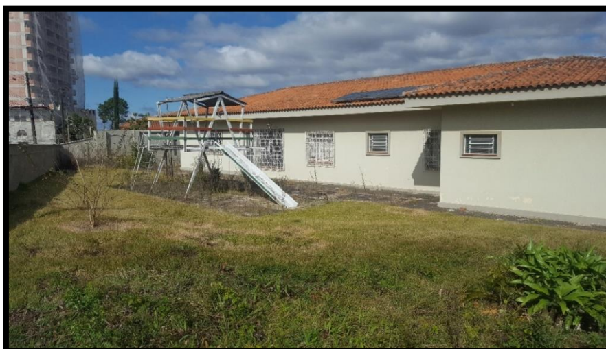
Figura 8: Edificação existente área de estudo Fonte: A autora (2017)
