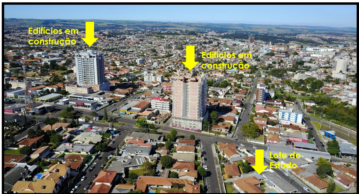
Figura 12: Edificações em construção no entorno Fonte: autora (2017)
