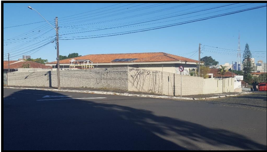
Figura 5: Edificação existente no lote Fonte: A autora (2017)
