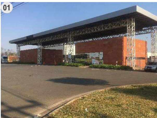
Figura 5: Vista da guarita e almoxarifado. Autor: Orbienge, 2021.
