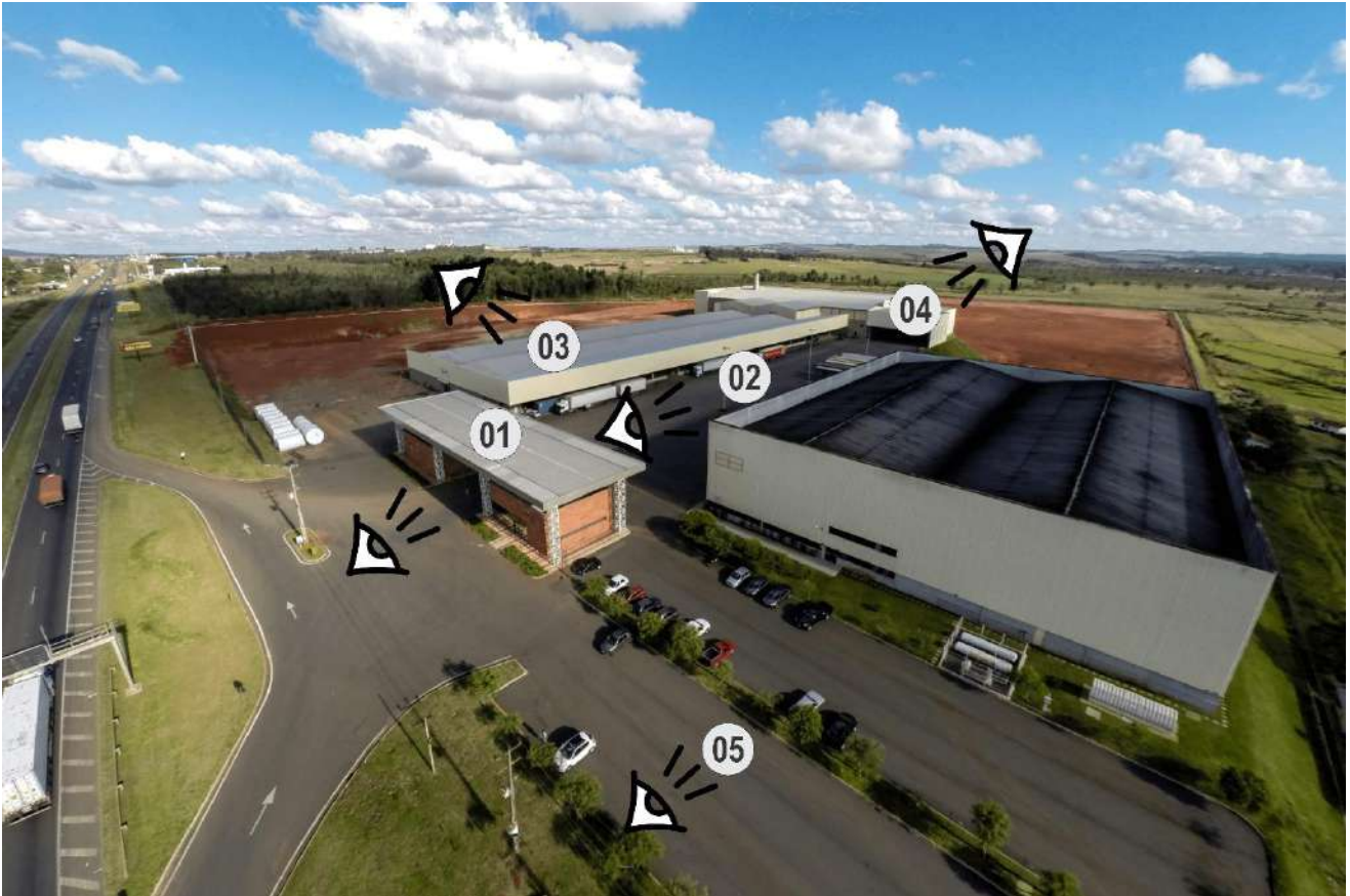
Figura 4: Vista aérea do empreendimento. Autor: Orbienge. 2021.
