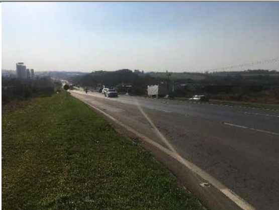
Figura 52: Faixa de desaceleração do acesso ao empreendimento. Autor: Orbienge, 2021.
