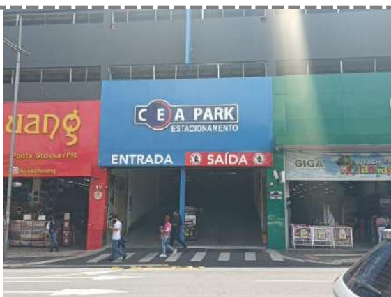
Figura 114: Vista do passeio no acesso à veículos do empreendimento na Avenida Doutor Vicente Machado. Autor: ORBIENGE, 2022.
