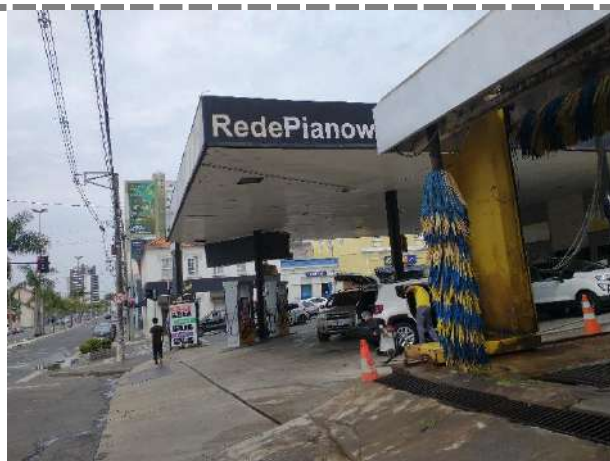
Figura 42: Atividades de serviço – Posto de Combustíveis. Autor: ORBIENGE, 2022.
