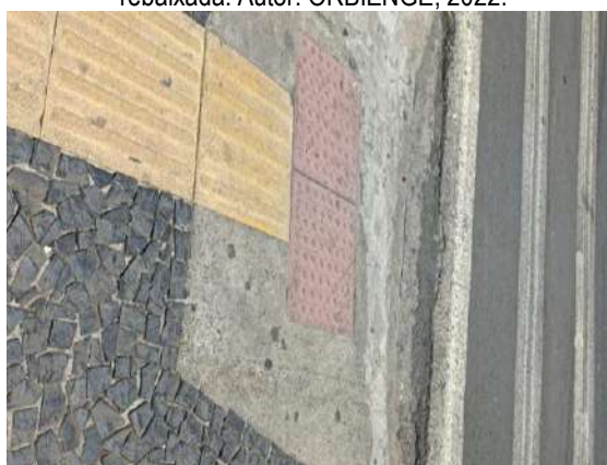
Figura 121: Vista parcial da esquina do Calçadão Coronel Claudio com a Rua Sete de Setembro dotado de sinalização tátil direcional, sinalização tátil de alerta e guia rebaixada. Autor: ORBIENGE, 2022.
