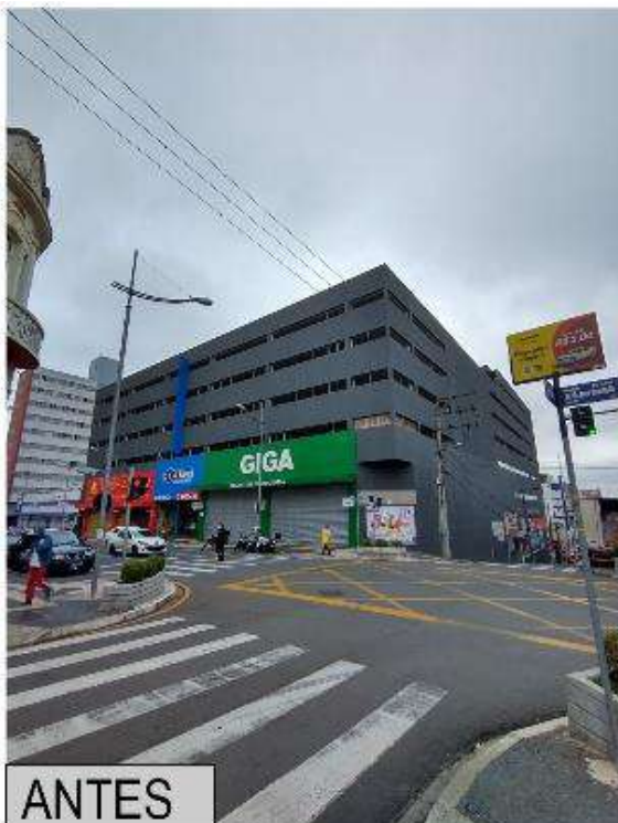
Figura 89: Vista do CEA antes da ampliação na esquina da Rua Santos Dumont com a Avenida Doutor Vicente Machado.
