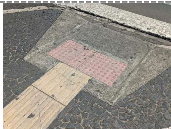
Figura 119: Vista parcial do passeio na Avenida Vicente Machado esquina com a Rua Santos Dumont dotado de sinalização tátil direcional, sinalização tátil de alerta e guia rebaixada. Autor: ORBIENGE, 2022.
