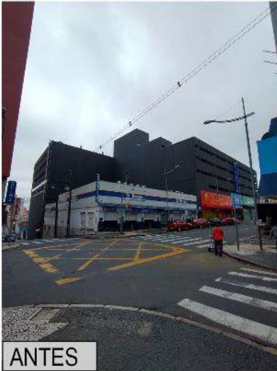
Figura 87: Vista do CEA antes da ampliação na esquina da Rua Sete de Setembro com a Avenida Doutor Vicente Machado.
