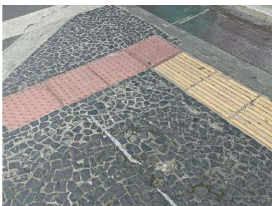
Figura 116: Vista parcial do passeio na Avenida Vicente Machado em frente ao acesso do estacionamento do CEA composto de sinalização tátil direcional e sinalização tátil de alerta. Autor: ORBIENGE, 2022.
