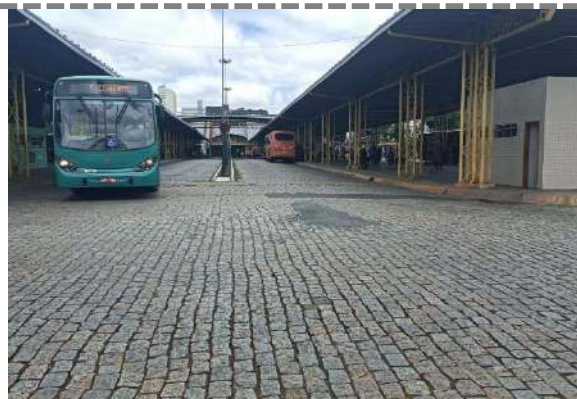
Figura 112: Vista da área interna do Terminal Urbano Central. Autor: ORBIENGE, 2022.
