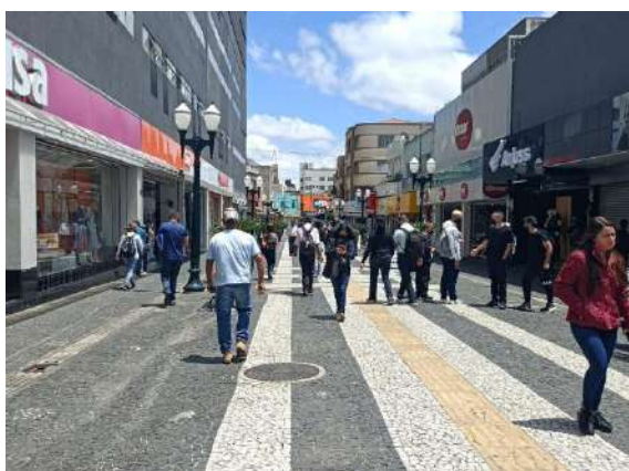
Figura 120: Vista do piso tátil direcional, localizado no Calçadão Coronel Claudio. Autor: ORBIENGE, 2022.
