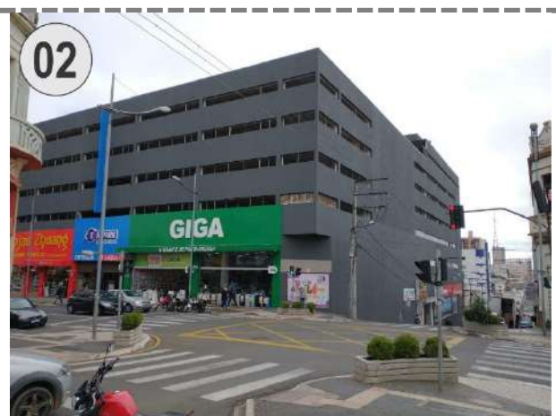
Figura 4: Vista do empreendimento de quem da esquina da Rua Santos Dumont com a Avenida Vicente Machado olha. Autor: Orbienge, 2022.
