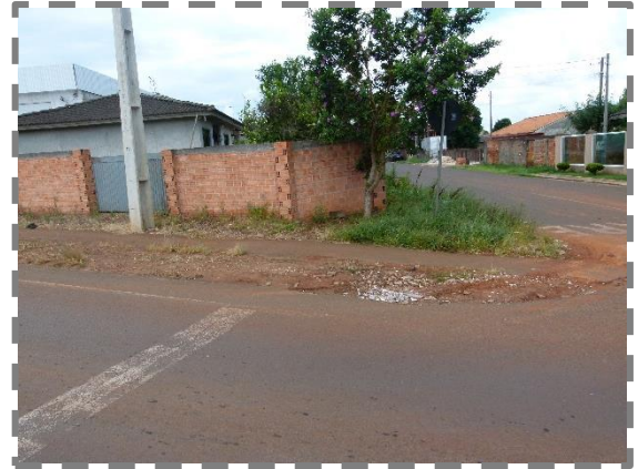
Figura 89: Vista da calçada da esquina entre as Ruas Siqueira Campos e Santa Bárbara. Autor: ORBIENGE, 2023.
