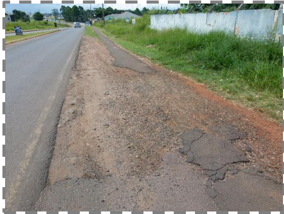
Figura 87: Vista da calçada da Rua Siqueira Campos. Autor: ORBIENGE, 2023.
