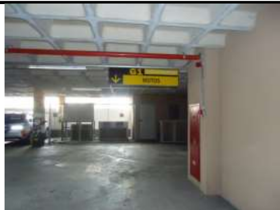
Foto 37 - Local para estacionamento de motos dentro do empreendimento.
