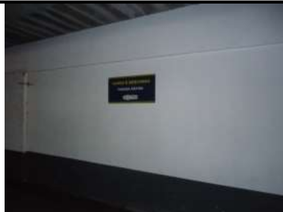
Foto 31 - Vaga destinada a carga e descarga.
