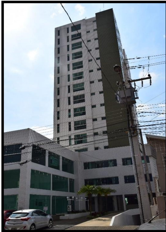
Figura 8: Edifício – Rua Coronel Francisco Ribas, nº 1011. Fonte: A Autora (2018)
