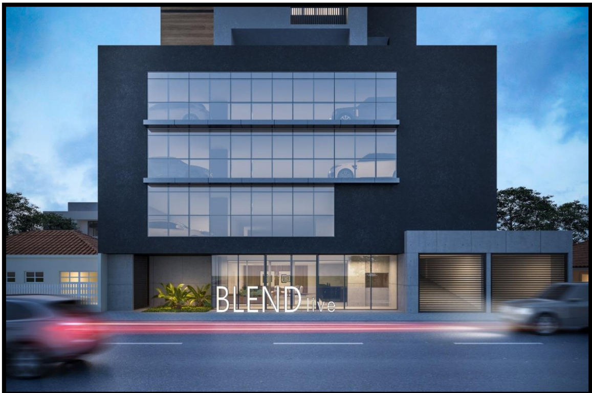
Figura 46: Acesso de pedestres Entrada Residencial – Representação Gráfica Fonte: Arquivo ECB Engenharia Civil (2018)
