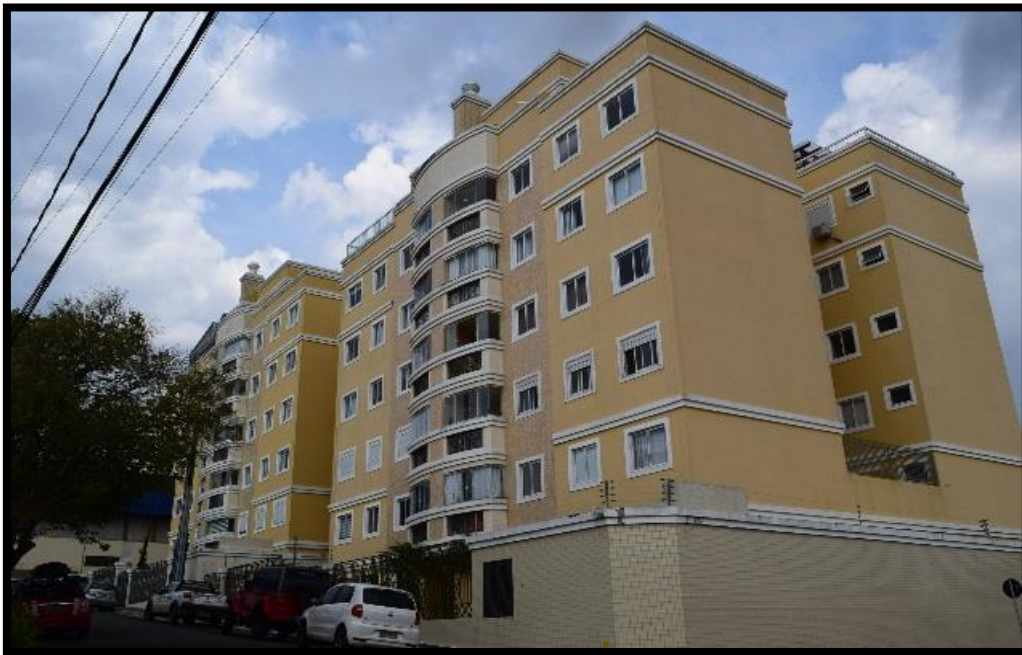
Figura 10: Edifício Rio Missisipi – Rua Concelheiro João Alfredo nº33 Fonte: A Autora (2018)
