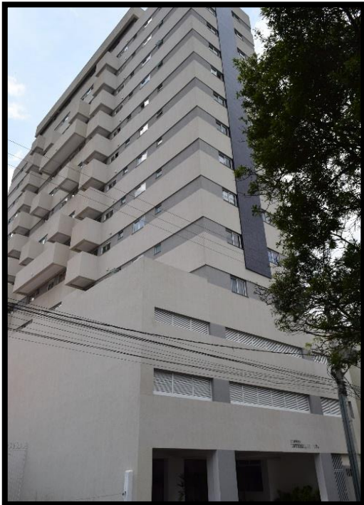
Figura 12: Edifício Estehefani – Rua Coronel Francisco Ribas nº532 Fonte: A Autora (2018)
