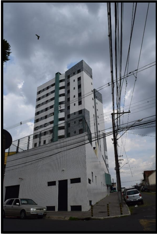
Figura 9: Edifício Michelangelo – Rua Rodrigues Alves, 554 Fonte: A Autora (2018)
