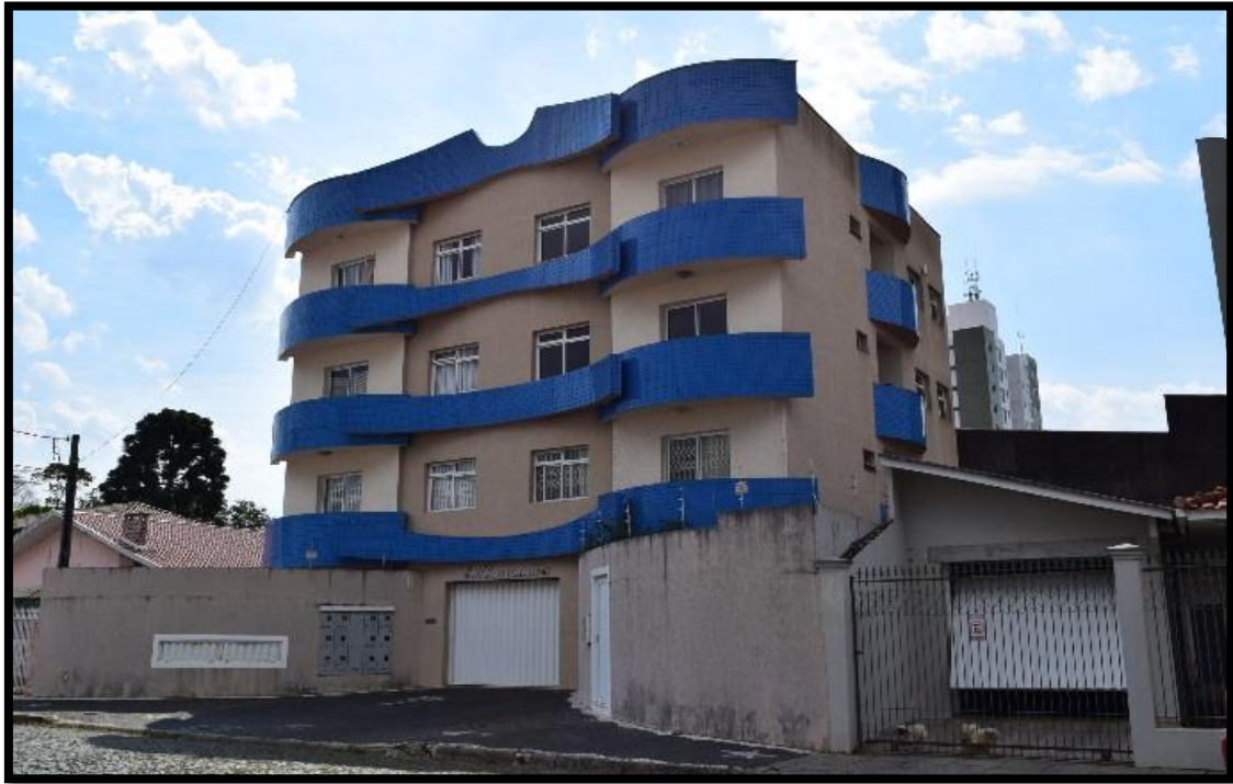
Figura 5: Edifício Cassiana – Rua Paulo Frontin nº48 Fonte: A Autora (2018)
