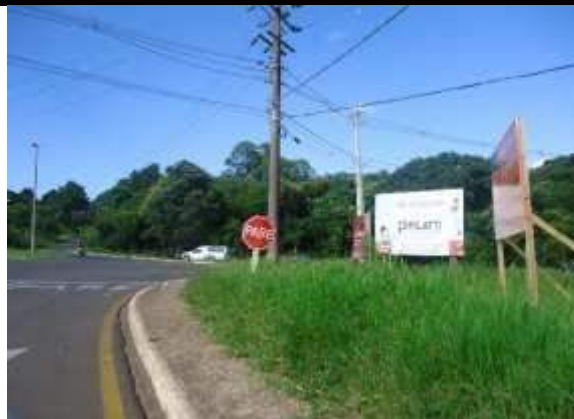
Foto 18 - Sinalização de "Pare" próximo a rotatória.
