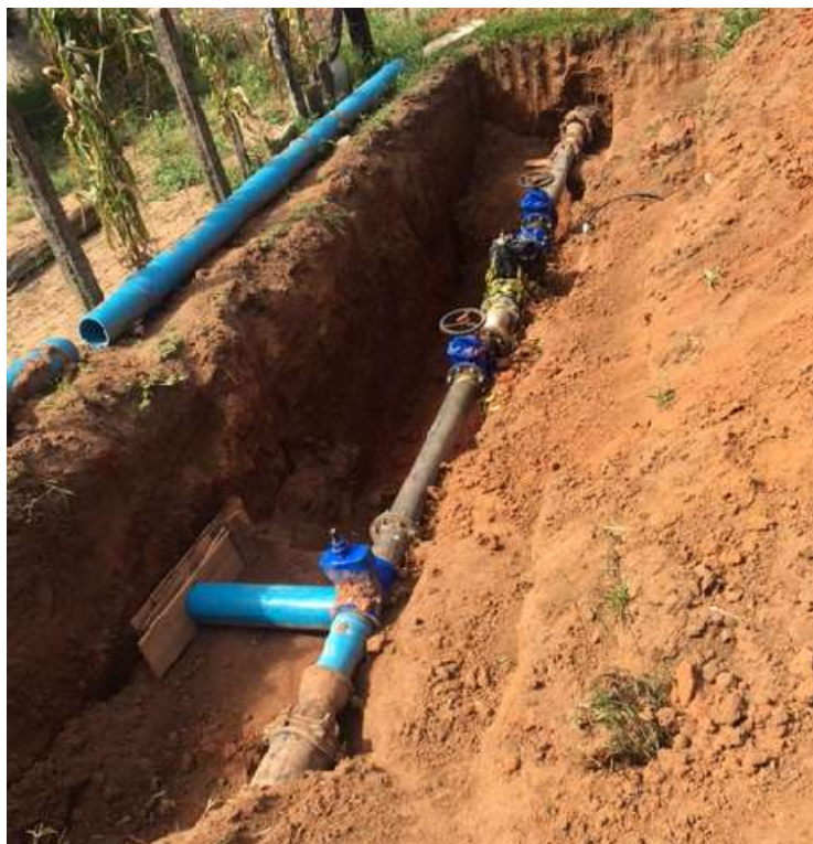
Figura 6: Registro fotográfico da rede de abastecimento água em fase de conclusão.
