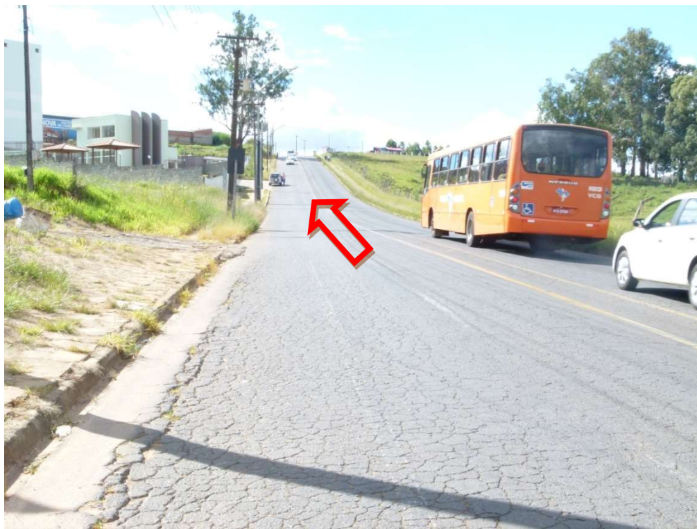
Figura 3: Vista da Rua Prefeito Albari Guimarães, sentido bairro-centro.
