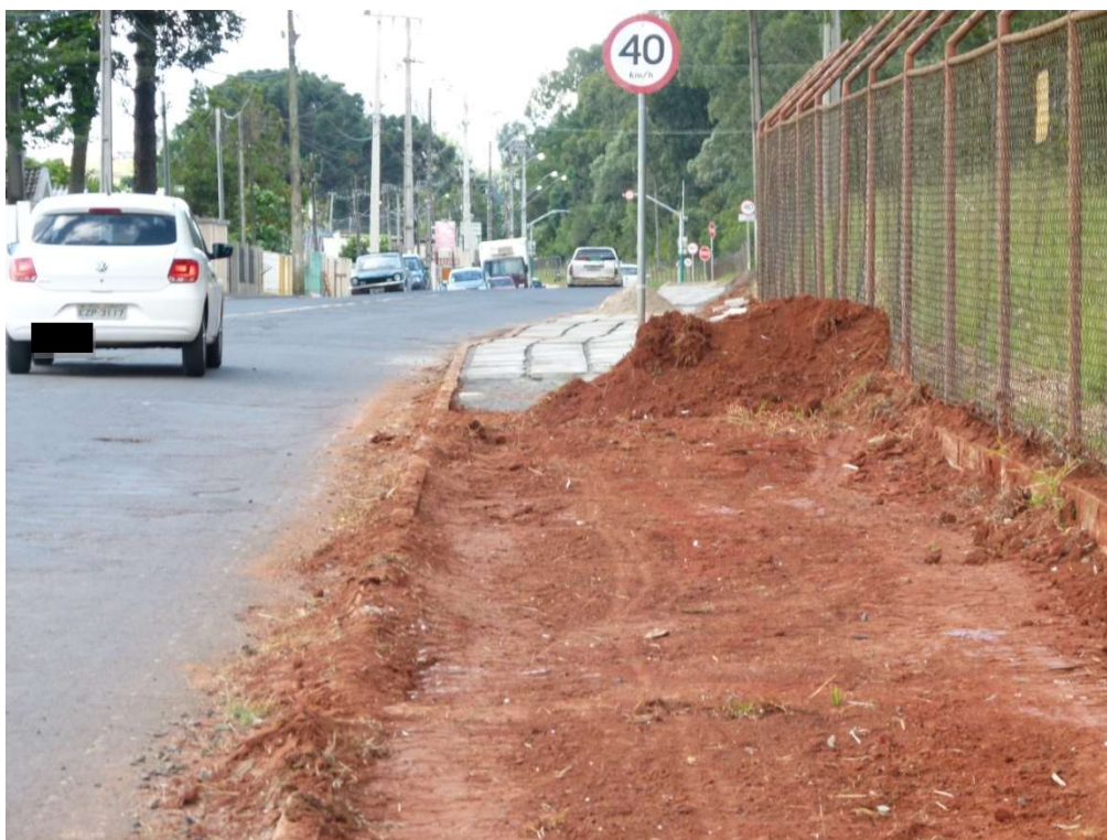
Figura 9: Vista do passeio em execução da Avenida General Aldo Bonde sentido bairro-centro.
