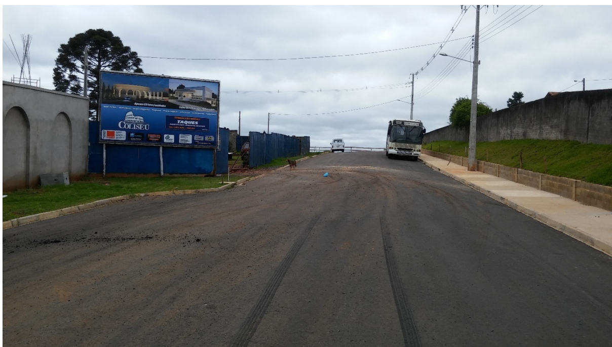
Foto 02 – Vista do trecho da Rua Francisco Martins Araújo entre a R. Visconde de Baraúna e o limite da gleba do Loteamento “Ecopark Pilão de Pedra” Detalhe o ponto onde a linha de divisa da gleba não concorda com o alinhamento da Rua Francisco Martins Araújo
