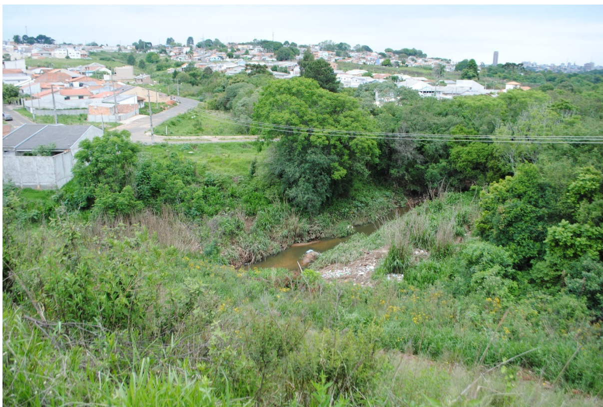
Foto 11 – Vista a montante da passagem do Pilão de Pedra sob a via férrea Observação do alto do aterro da via férrea da área de domínio público onde se pretende implantar o reservatório de retenção de enchentes
