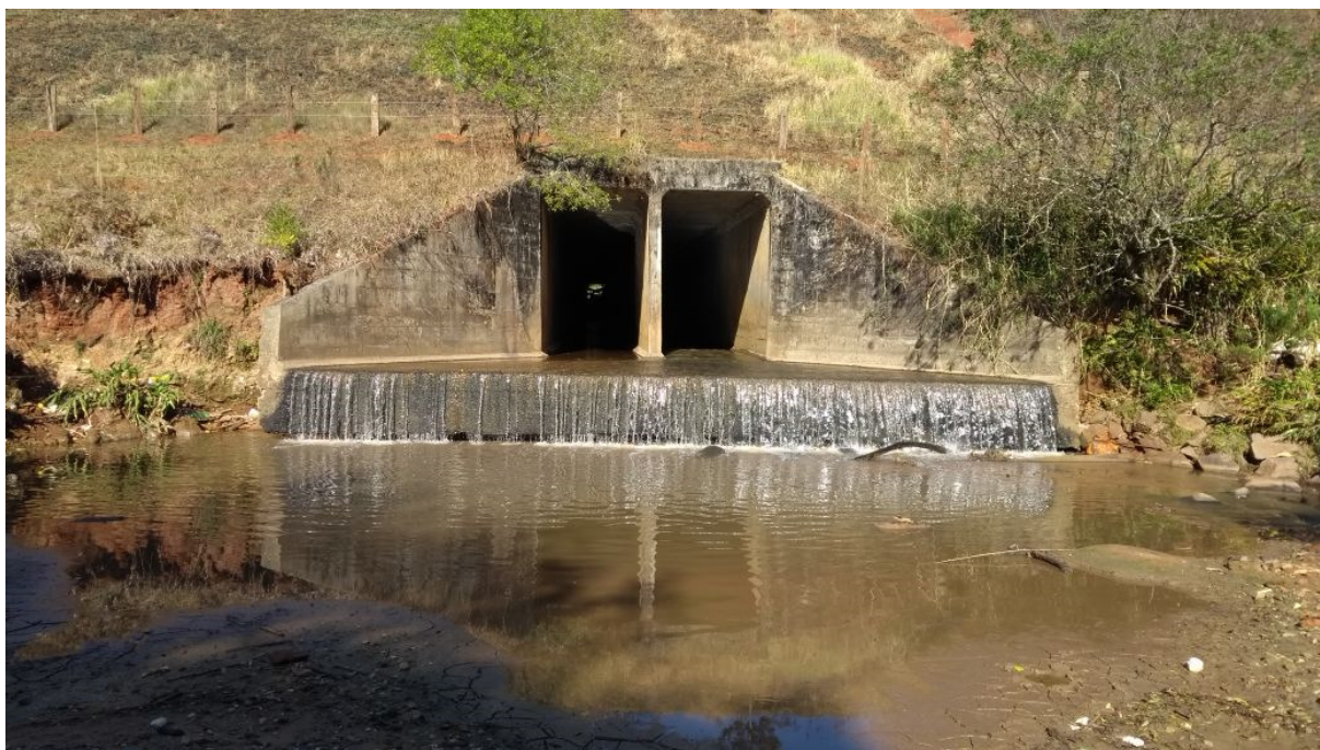
Foto 12 – Vista a jusante da travessia do Pilão de Pedra sob a via férrea, com detalhe das duas seções 2,00 x 3,00 m
