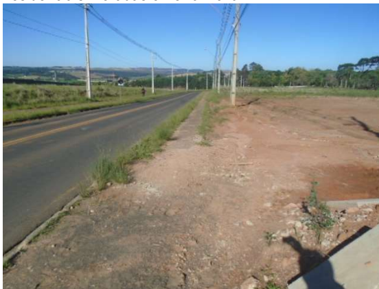
Figura 60: Vista da Rua Antônio Saad.
