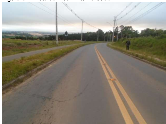
Figura 63: Vista da Rua Antônio Saad
