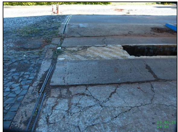
Detalhes dos pisos e canaletes
