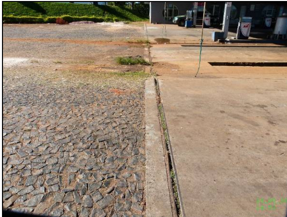
Detalhes dos pisos e canaletes
