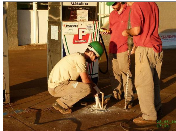
Momento da perfuração do piso do pátio de abastecimento – 0,5 e 1 metro
