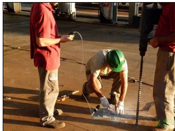
Retirada da broca de perfuração e imediata colocação da sonda para análise de COV's
