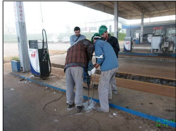
Momento da perfuração do piso junto as bombas – 0,5 e 1 metro
