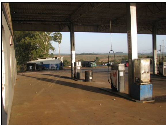
Detalhe das bombas de etanol e gasolina
