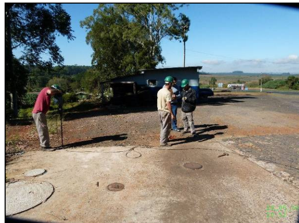
Momento de medição de COV's na área de descarga
