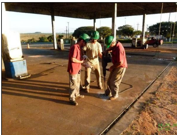
Momento da perfuração do piso – 0,5 e 1 metro
