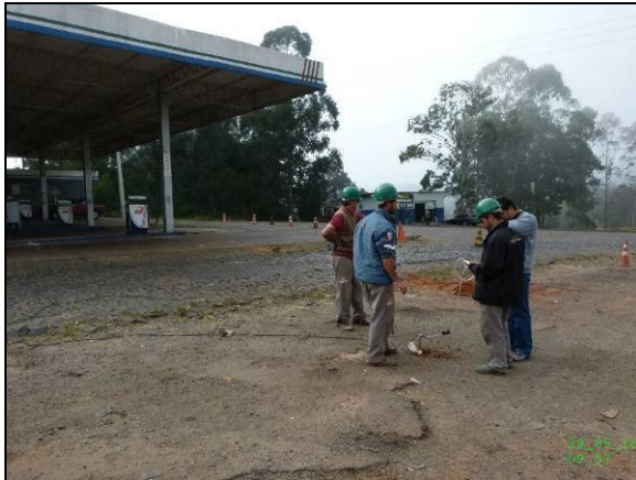
Momento de medição de COV's - piso permeável seguindo maiores anomalias encontradas
