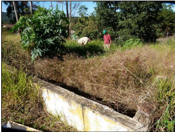
Sondagem ST05 – detalhe da caixa separadora desativada
