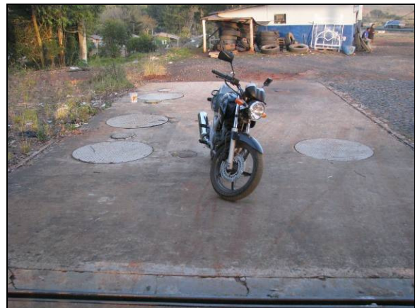
Detalhe da área de descarga
