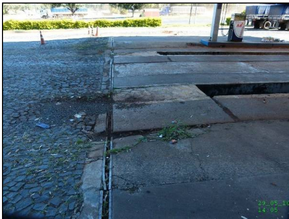
Detalhes dos pisos e canaletes
