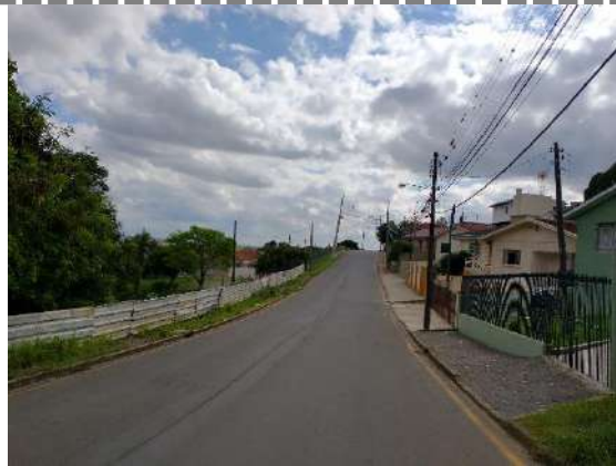
Figura 89: Vista parcial do passeio da Rua Barão de Monte Alegre. Autor: ORBIENGE, 2021.
