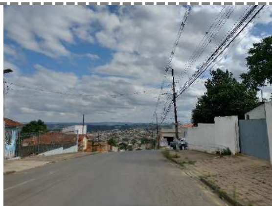
Figura 87: Vista parcial do passeio da Rua Teixeira de Freitas. Autor: ORBIENGE, 2021.
