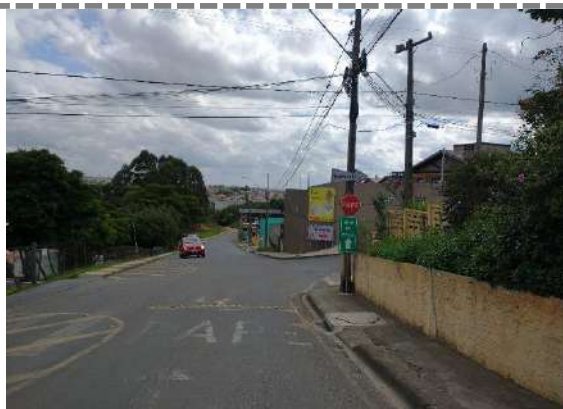
Figura 90: Vista parcial do passeio da Rua Fontoíno Xavier Domingos de Magalhães. Autor: ORBIENGE, 2021.
