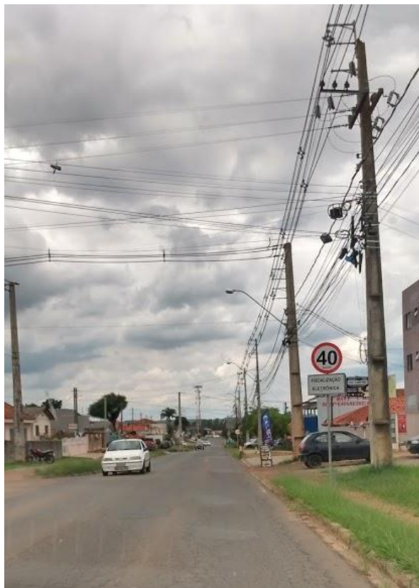
Figura 8 – Avenida Antônio Saad em direção ao condomínio
